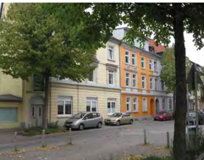
Foto: Bereits sanierte Häuserzeile
