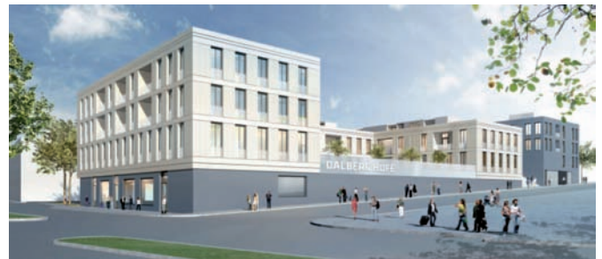
Visualisierung des modifizierten Konzeptes und Foto des fertigen Gebäudeensembles von Nord-Osten
