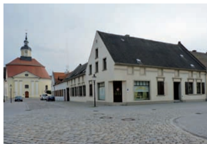
Oranienbaum, Sanierungsobjekt in der Marktstraße und Straßenerneuerung in der Kirchstraße
