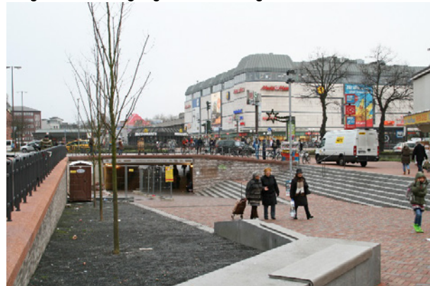
Umgestaltete Fußgängerunterführung zum Bahnhof Altona
