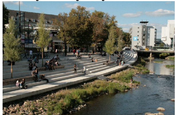
Ufer der Sieg nach der Umgestaltung
