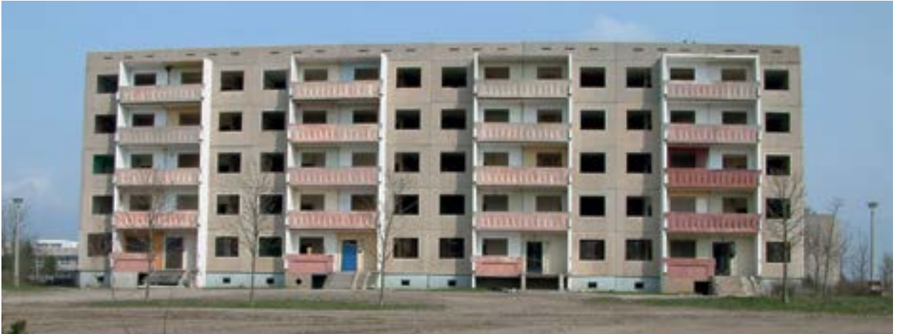
In Wolfen-Nord stand im Jahr 2000 circa ein Drittel der 13.000 Wohnungen leer. Bis 2010 wurden über 6.000 Wohneinheiten abgerissen.
