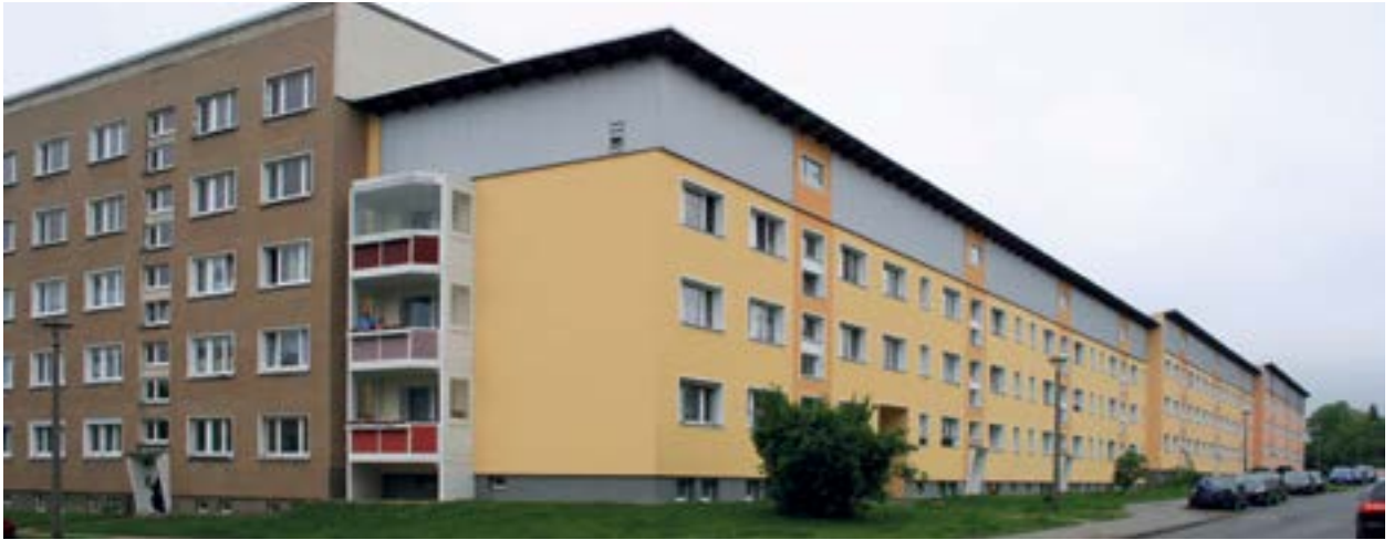
Stillgelegte Obergeschosse in Görlitz
