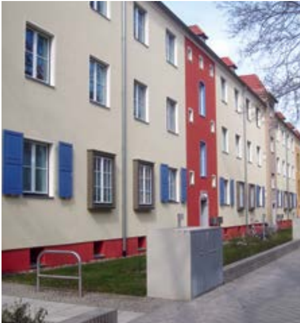
Die städtische Wohnungsbaugesellschaft wobra hat in Brandenburg an der Havel innerstädtische Bestände aus den 1920er Jahren denkmalgerecht saniert.
