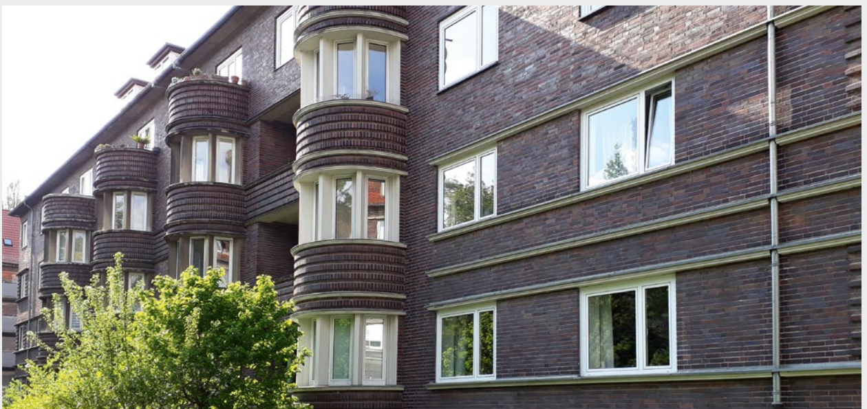
Südstadt Hannover: Die Fassaden sind durch einheitliches Material und expressionistische Gestaltungsmotive geprägt | Foto: Dr. Holger Pump-Uhlmann
