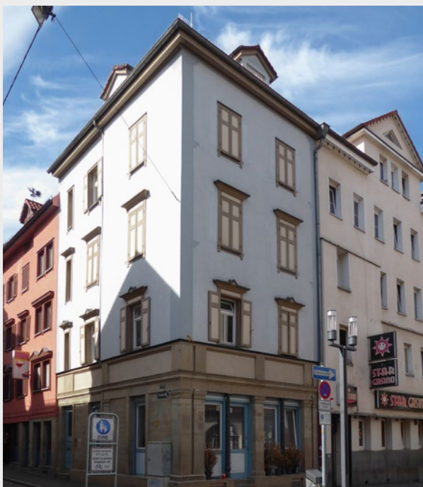
Eckhaus am Leonhardsplatz | Foto: Annegret Kaiser
