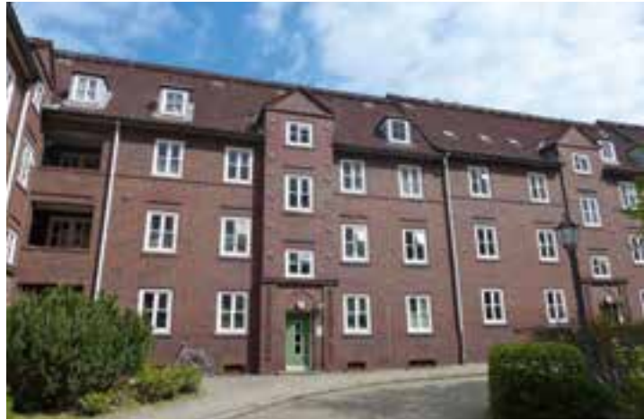
Hamburg-Dulsberg, Wohngebäude der Schiffszimmerer, öffentlicher Eingangshof, 2018
