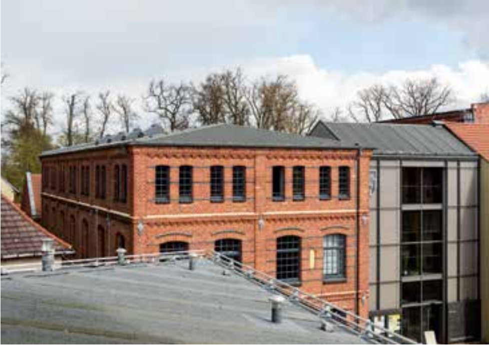
Wittstock/Dosse, Stadtverwaltung, sanierter Altbau mit Neubau, 2017
