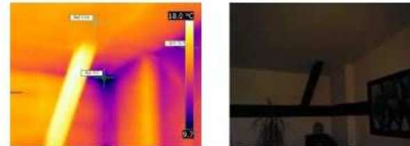
Abb. 51 IR-Aufnahme Sangerhäuser Straße 35 Dachgeschosswohnung
