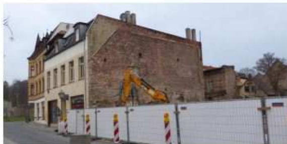
Abb. 49 Sangerhäuser Straße 35 Ostansicht
