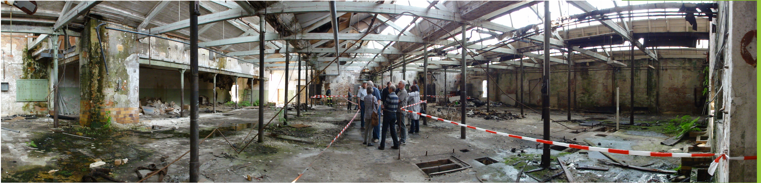
Shedhalle vor der Sanierung
