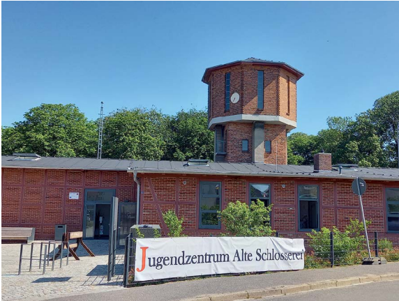
Neue Nutzung des baukulturellen Erbes in Wittstock/ Dosse: Umbau einer ehemaligen Schlosserei zum Jugend- zentrum
