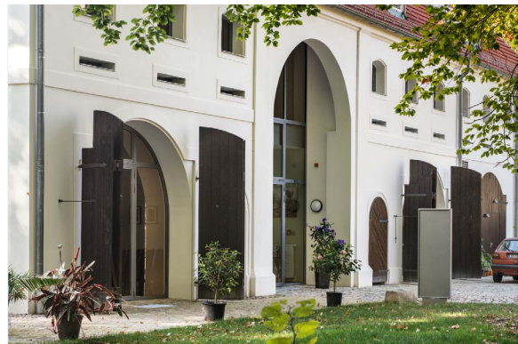
Sanierung und Umbau der Alten Darre des Schlosses Lieberose zu einem Bürgerzentrum mit Touristeninformation, Museum, Bürgersaal und Restaurant
