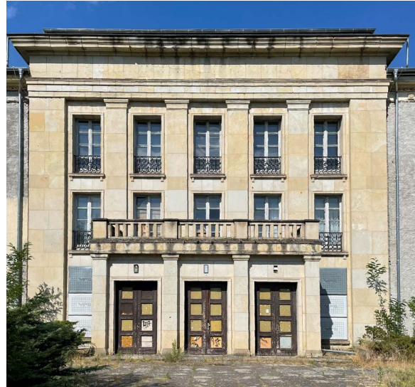
Außenansicht des ehem. Lektionsgebäudes Bogensee
