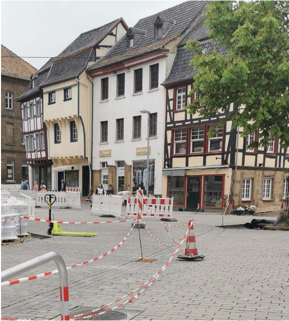
Nach der Flutkatastrophe ist im Mai 2022 die neue Pflasterung in der Altstadt von Bad Münstereifel fast abgeschlossen
