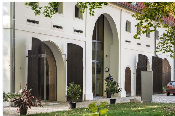
Sanierung und Umbau der Alten Darre des Schlosses Lieberose zu einem Bürgerzentrum mit Touristeninformation, Museum, Bürgersaal und Restaurant
