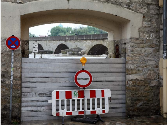
Hochwasserschutz in Regensburg
