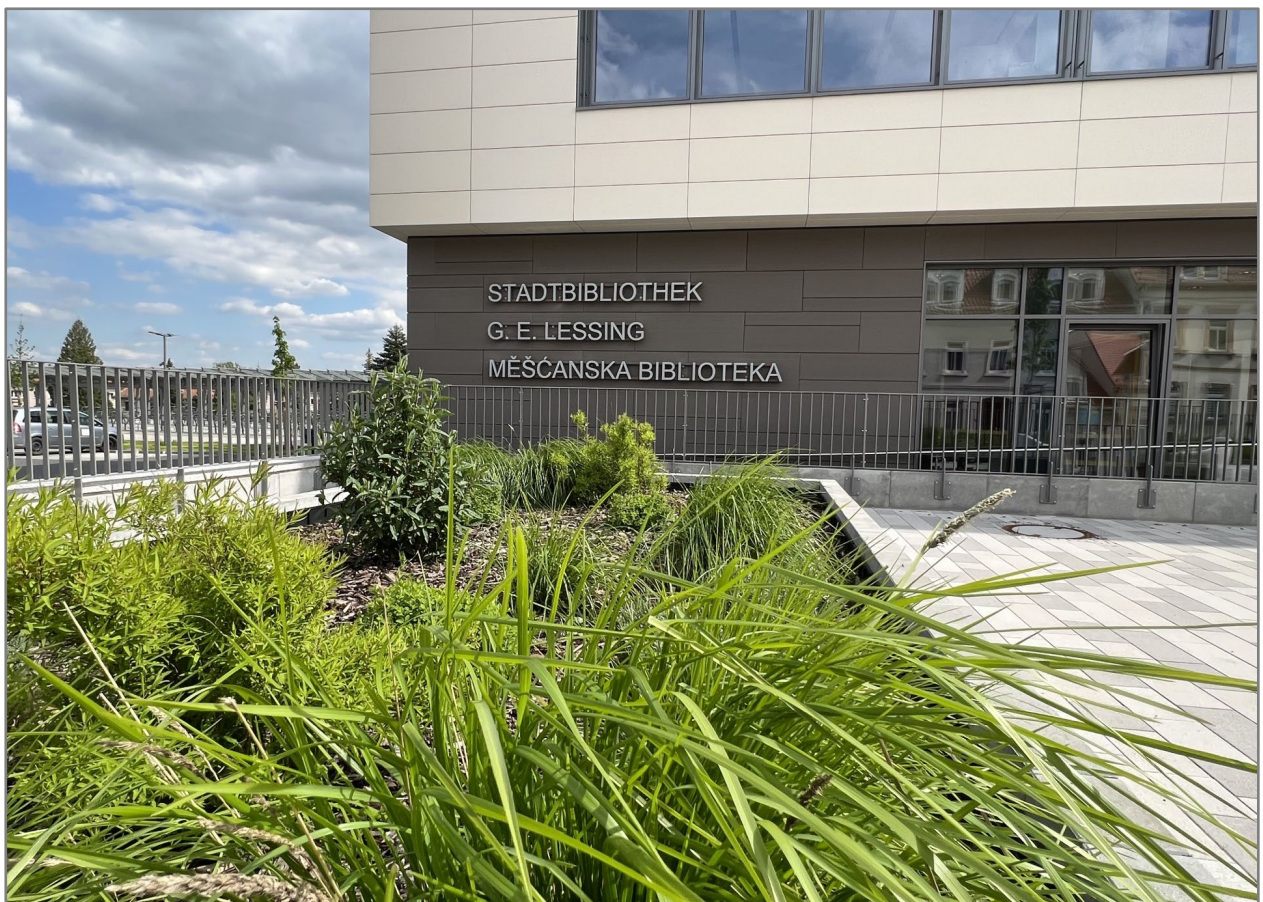
Außenansicht der neu errichteten Lessing-Bibliothek, Kamenz (Copyright: Studio Hasselbach)
