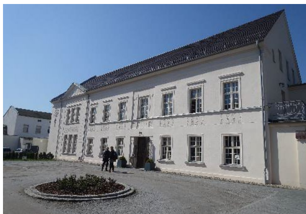
Die sanierte Freimaurerloge
