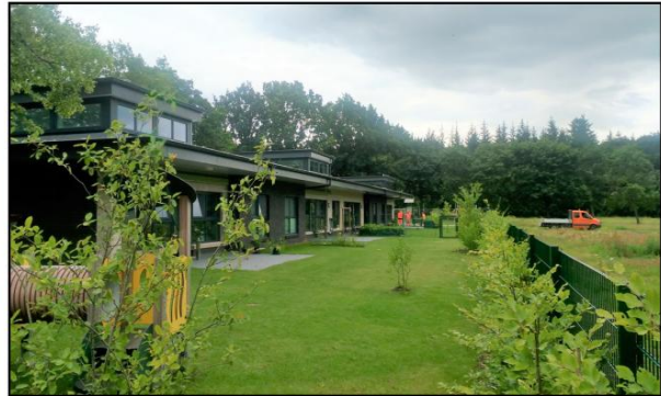
Neubau eines Kindergartens
