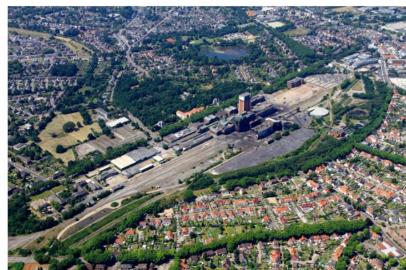
Luftbild Kamp-Lintfort „Zeche Friedrich Heinrich“ Quelle: Stadt Kamp-Lintfort
