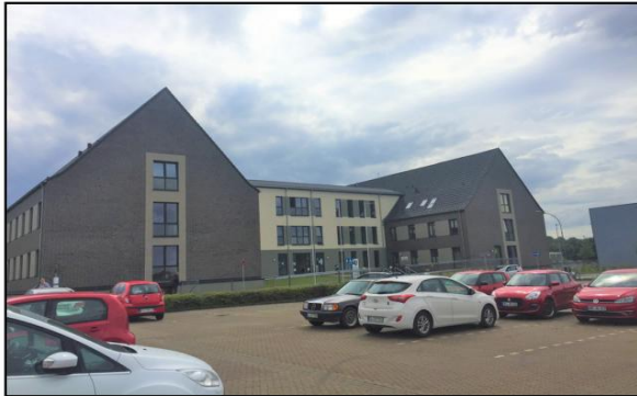
ehem. Mannschaftshaus zum KDLZ umgebaut
