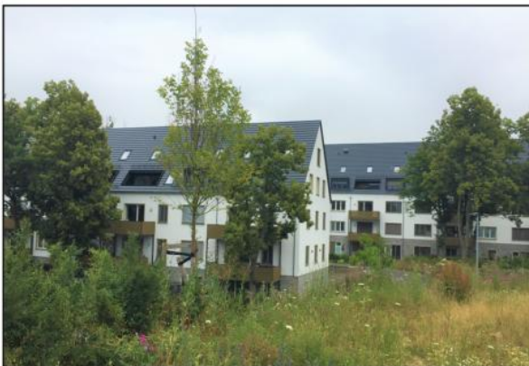
Sanierte Bestandsgebäude: ehem. Mannschaftshäuser
