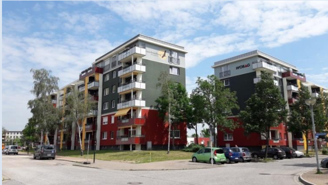
Aufgewertete Plattenbaubestände in der Innenstadt Fotos: jeweils Bundestransferstelle Stadtumbau
