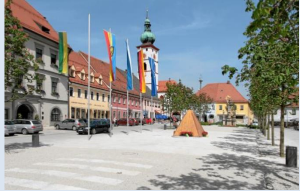
Marktplatz nach Abschluss der Umbauarbeiten Foto: Stadt Tirschenreuth
