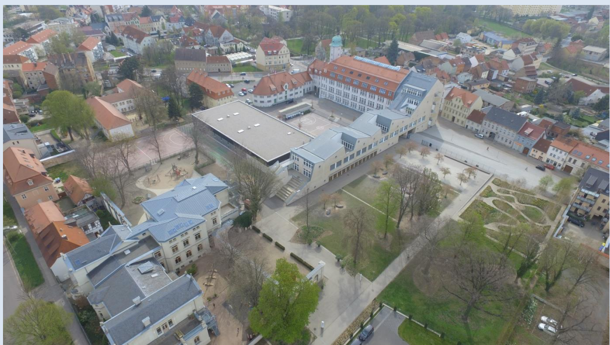
Blick von Nordwesten auf das Bildungszentrum Bestehornpark
