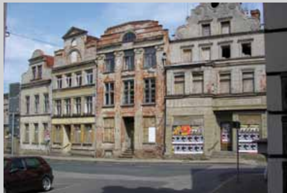
Unsanierte, leerstehende Gebäude „Am Berge“
