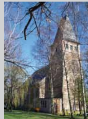
Die St.-Martin-Kirche nach der Sanierung
