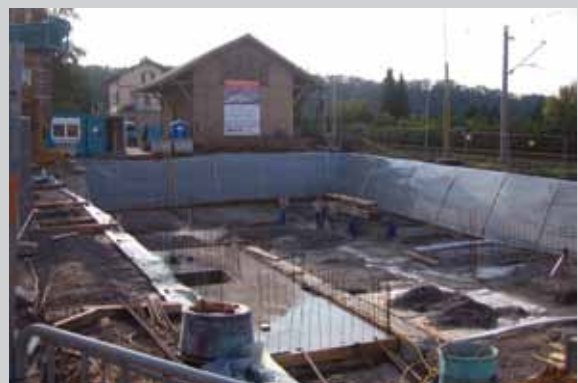
Bau eines Handels- und Dienstleistungszentrums auf dem Bahnhofsvorplatz im Ortskern Burgstall
