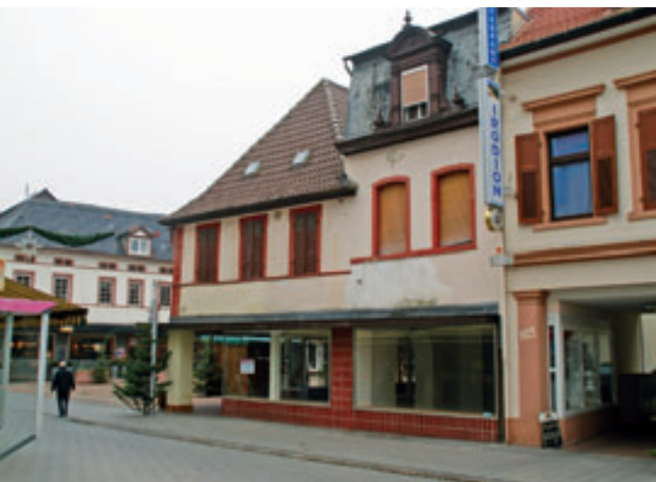
Die Sicherung der Nahversorgung ist insbesondere in kleinen Städten von Bedeutung (oben); in vielen Städten bestehen städtebauliche Missstände.
