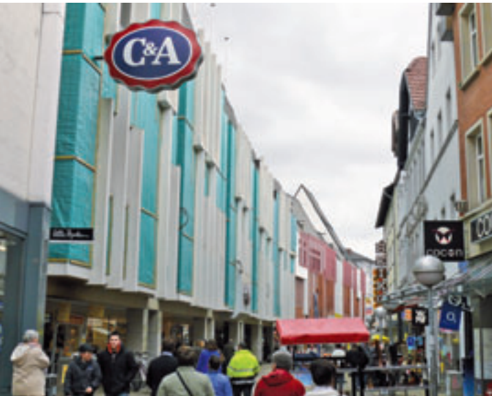
Umbau eines Bekleidungshauses in der Mindener Innenstadt
