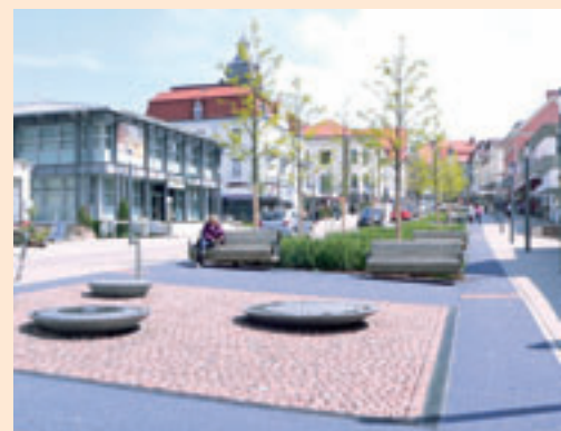
Brunnenallee vor und nach der Umgestaltung zur Begegnungszone; neue Spiel- und Aufenthaltsfläche (von oben nach unten)
