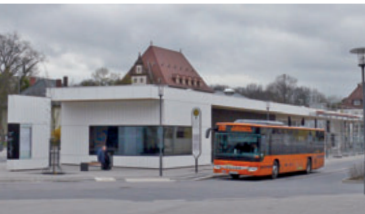
Barrierearme Gestaltung der Unterstraße in Wadern (oben); der neue ZOB in Minden
