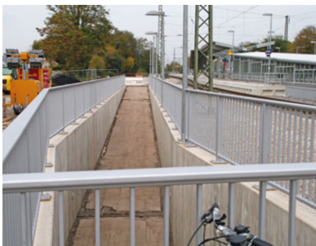
Barrierefreier Zugang Bahnhof Emmendingen
