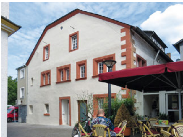
Saniertes Wohn- und Geschäftshaus in Wittlich
