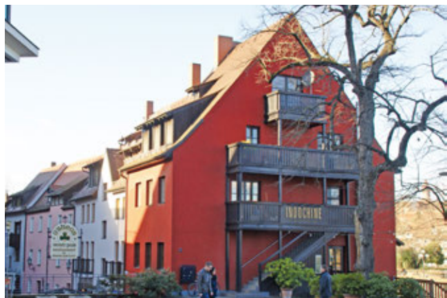
Energetisch saniertes Gebäude in Nürnberg
