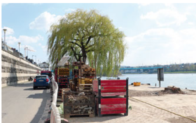
Schutz vor Rheinhochwasser: Umgestaltung Deichvorgefläche Neuwied
