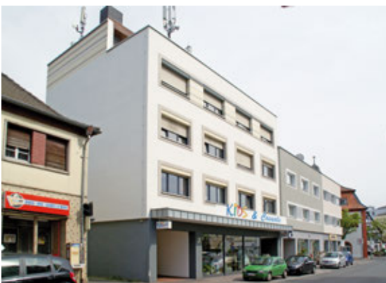
Saniertes Wohn- und Geschäftshaus am Marktplatz Bürstadt
