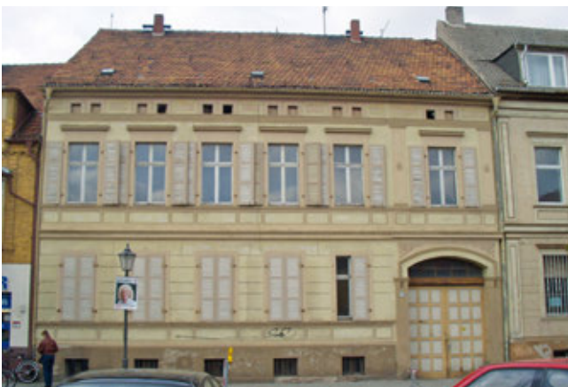
Stadtbildprägendes Gebäude in Luckenwalde vor der Sanierung
