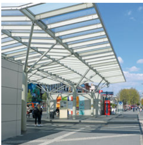
Neue zentrale Busstation in Neuwied
