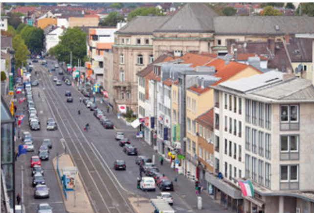
Friedrich-Ebert-Straße in Kassel vor dem Umbau
