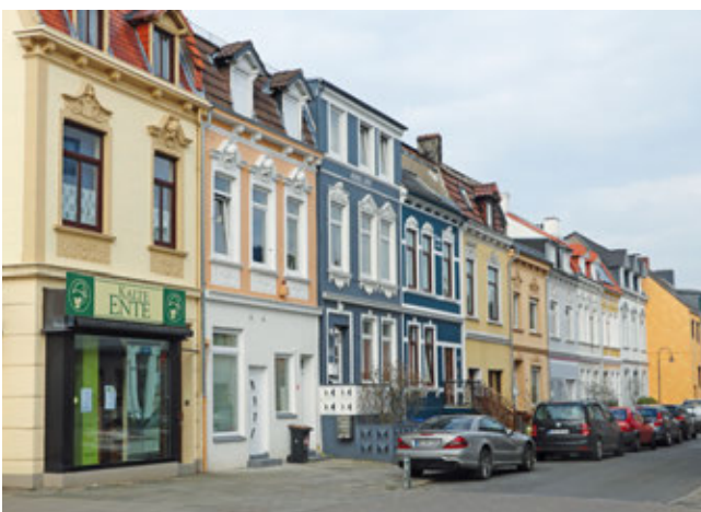
„Bremer Häuser“ in der Grenzstraße in Bremen-Walle
