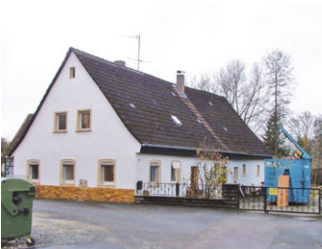
Bürgerhaus Litzendorf vor der Sanierung
