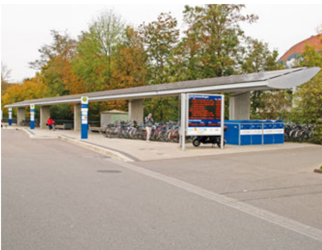
Busbahnhof Emmendingen mit Fahrradabstellanlagen
