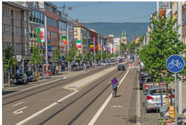
Friedrich-Ebert-Straße in Kassel nach dem Umbau
