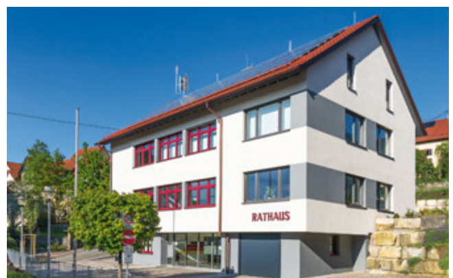
Energetisch saniertes Rathaus in Burgstetten
