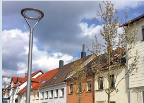
Neue Beleuchtung in der Bahnhofstraße
