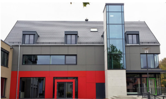
Alte Feuerwehr Gerbrunn nach der Sanierung
