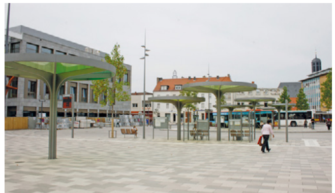
Neu gestalteter Busbahnhof Hanau
