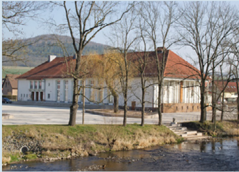
Energetisch saniertes, denkmalgeschütztes Kulturhaus
