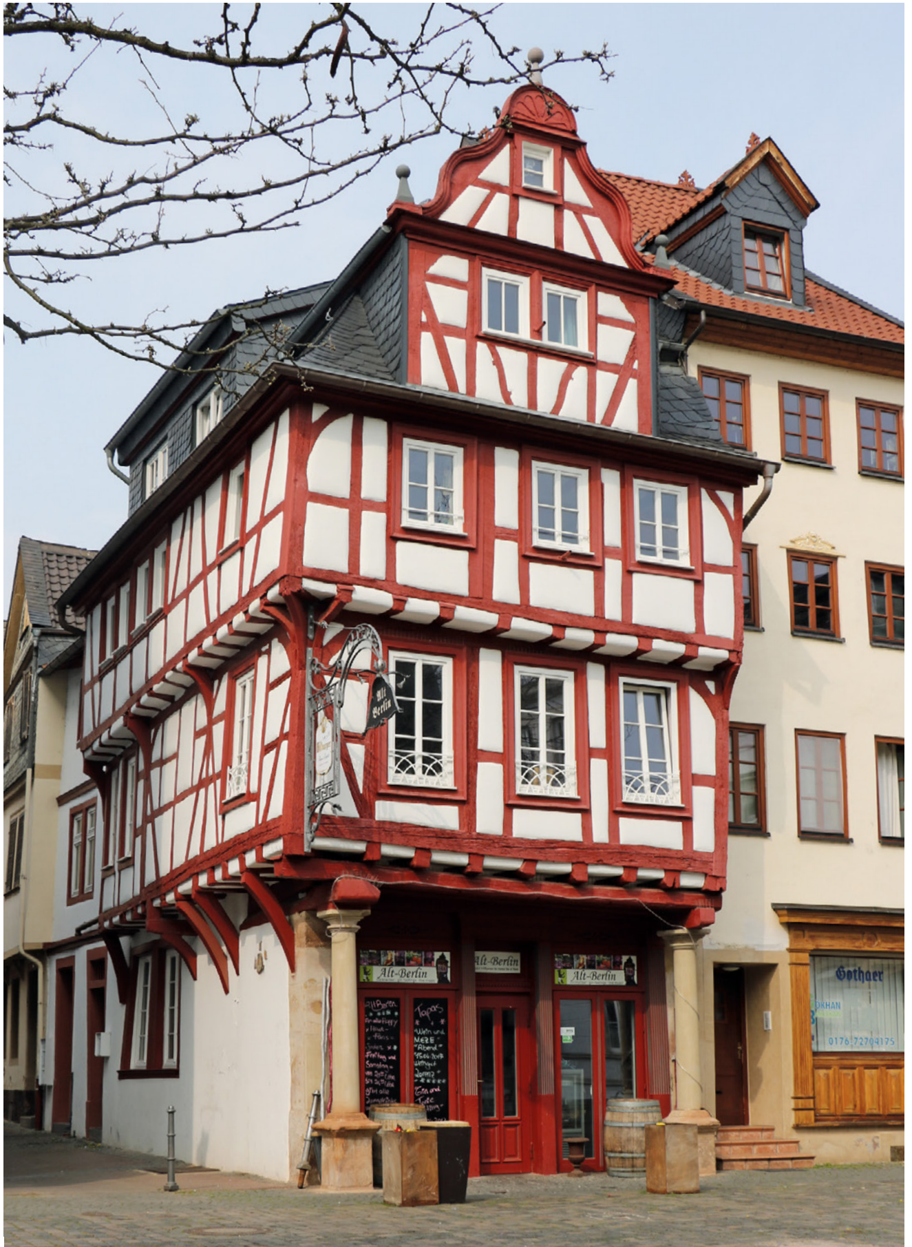
Modernisiertes Gebäude in Bad Kreuznach
