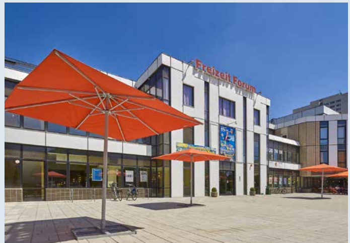
Energetische Sanierung des Freizeitforums Marzahns läuft.
