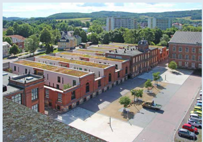
Neubauten hinter der historischen Fassade schaffen Funktionsvielfalt.
