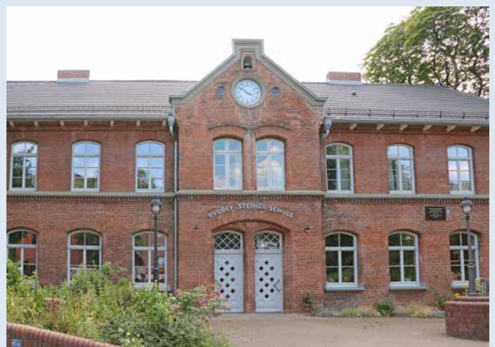
Historisches Vorderhaus der sanierten Rudolf-Steiner-Schule
