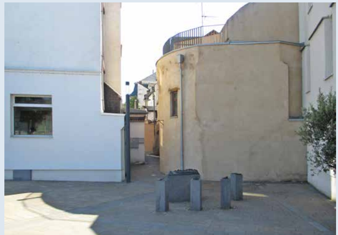
Der freigelegte Löhrturm mit Stadtmodell im Vordergrund
