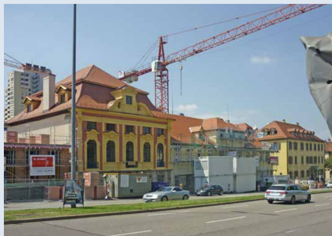
Sanierung stadtbildprägender Gebäude
