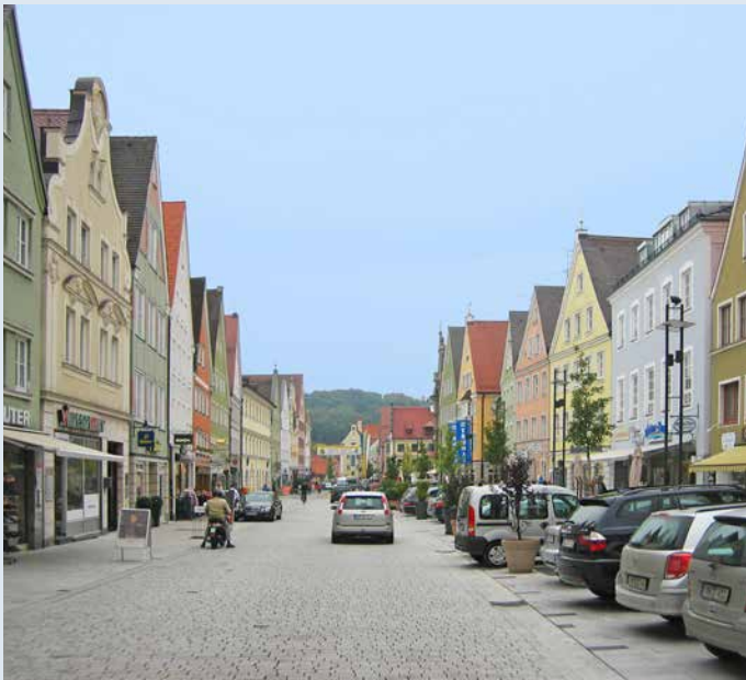
Mehr Raum für Fußgänger: umgestaltete Maximilianstraße
