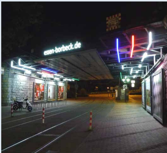
Neue Lichtinstallation der Bahnunterführung
