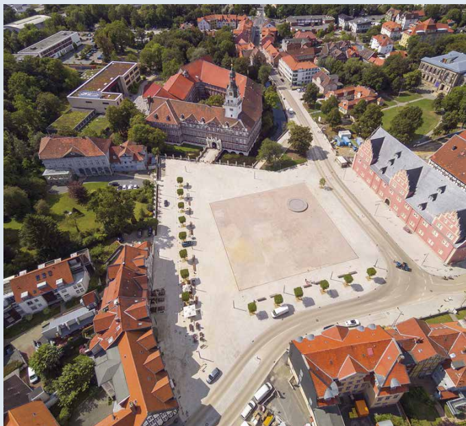
Straßenverlegung und Neugestaltung attraktivieren Schlossplatz
