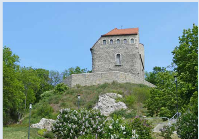
Hausmannsturm nach der Sanierung
