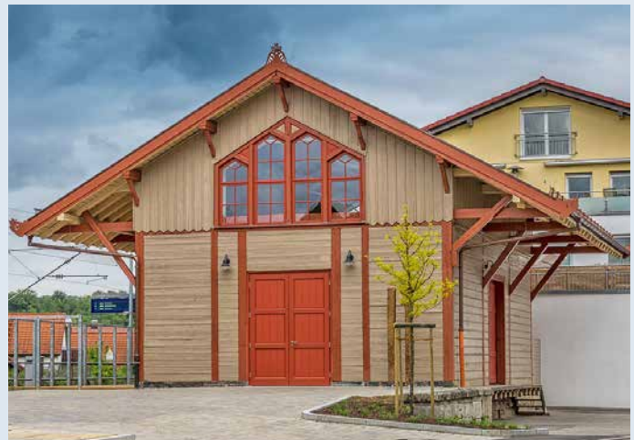
Neuer Veranstaltungssaal im denkmalgeschützten Güterschuppen
