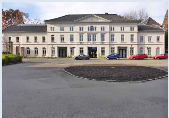
Saniertes Wirtschaftsgebäude im Schlosspark dient Bildung und Kultur.
