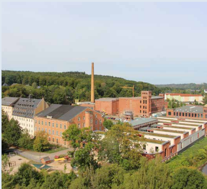
Im Umbau: Gelände der Alten Baumwolle in Flöha
