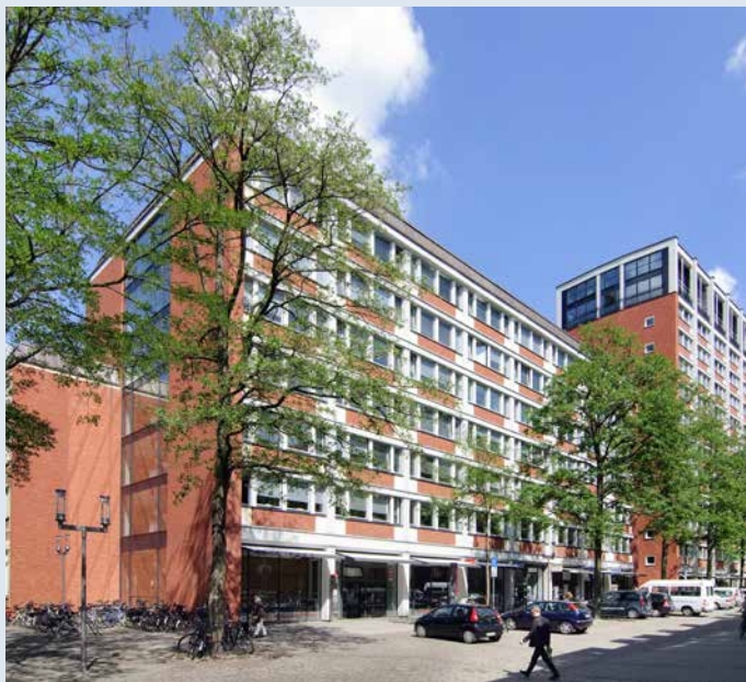
Denkmalgeschütztes Stadthaus nach der Sanierung
