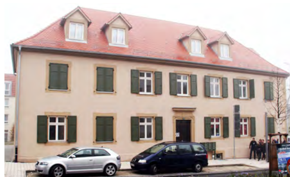
Saniertes Gebäude mit Studentenwohnungen auf dem Walcker-Areal
