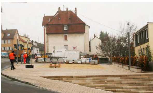
Neuer Stadtplatz nach Rückbau von Erschließungsanlagen im Umfeld des Marstall-Centers
