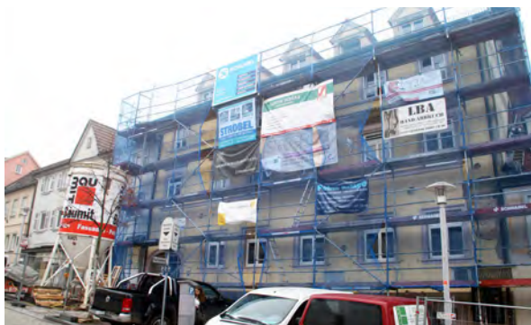
Sanierungsmaßnahme zur Qualifizierung des Wohnungsbestandes
