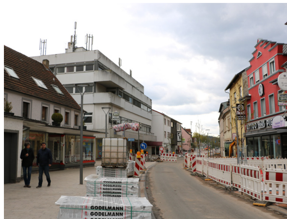
Bahnhofstraße Bexbach während des Umbaus
