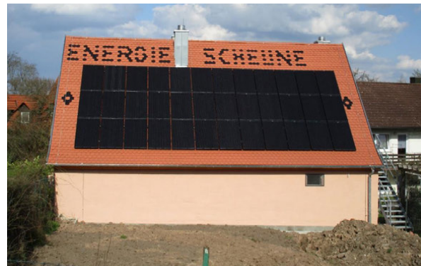
Energiescheune vor und nach dem Umbau Fotos: Markt Uehlfeld
