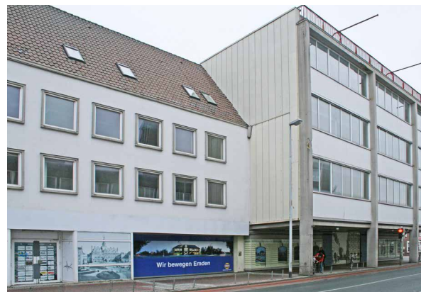
Leergefallene Kaufhalle vor Rückbau Foto: Plan und Praxis
