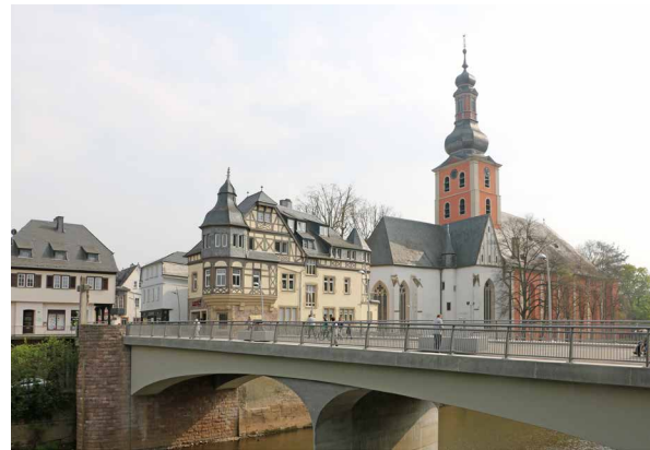
Alte Nahebrücke in Bad Kreuznach nach der Sanierung Foto: Plan und Praxis
