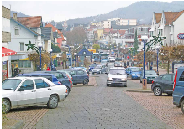
Brunnenstraße vor dem Umbau Foto: Plan und Praxis
