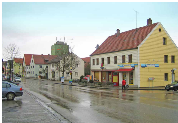
Ansicht der Ingolstädter Str. vor dem Umbau (2009) Foto: Herbert Nerb, Markt Manching
