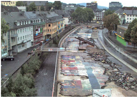
Vor dem Umbau: Abriss der Siegplatte Foto: Stadt Siegen
