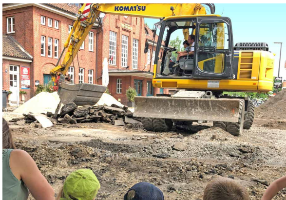
Baustellenbesichtigung durch einen Kindergarten Foto: Stadt Langenhagen
