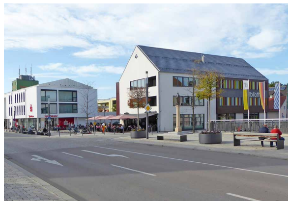
Ansicht der Ingolstädter Str. nach dem Umbau (2019) Foto: Herbert Nerb, Markt Manching
