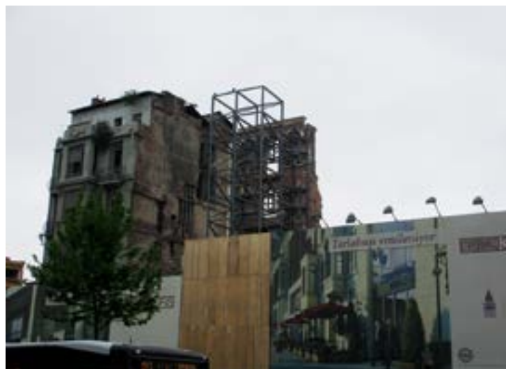
Abb. 4: Tarlabası: Erhalt einer Häuserfassade, das Haus dahinter wird komplett neu errichtet (Foto: Tobias Schäfer)
