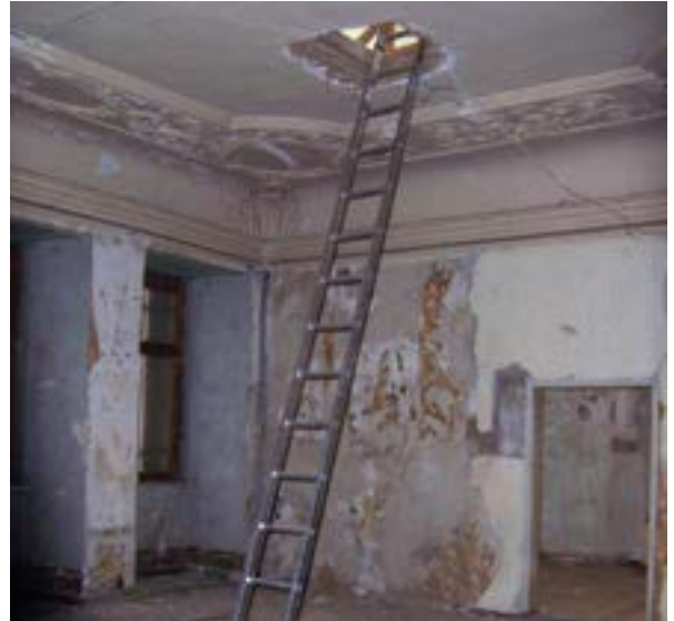
Abb. 3: Innenbereich mit Stuckdecke und provisorischer Erschließung (Foto: Eckhard Hasler)
