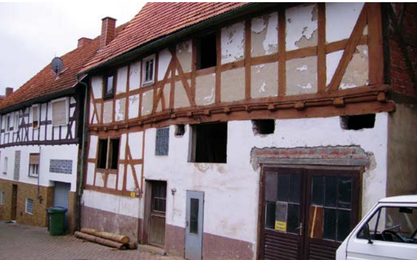
Abb. 5: Gebäude in Sachsenberg (Lichtenfels) vor der Sanierung (Foto: Landesamt für Denkmalpflege Hessen)
