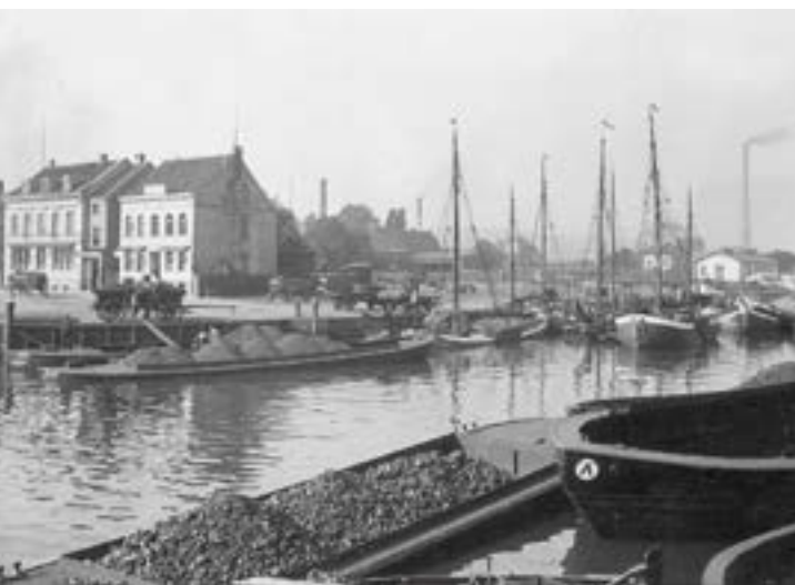
Abb. 7: Lotsekanal um 1900. Kanalplatz mit Kontorhäusern, das linke wurde im Rahmen des Förderprogrammes teilsaniert. (Foto: Helms-Museum Hamburg)
