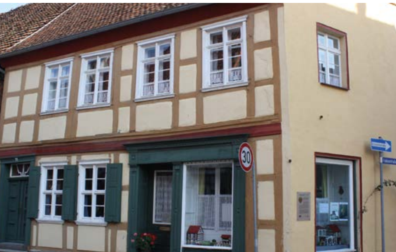
Abb. 1: Fachgerecht restauriertes ehemaliges Schusterhaus (Foto: privat)
