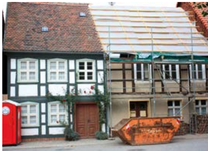
Abb. 3: Denkmalgerechte Restaurierung ehemaliger Wohnhäuser zu Ferienwohnungen (Foto: privat)
