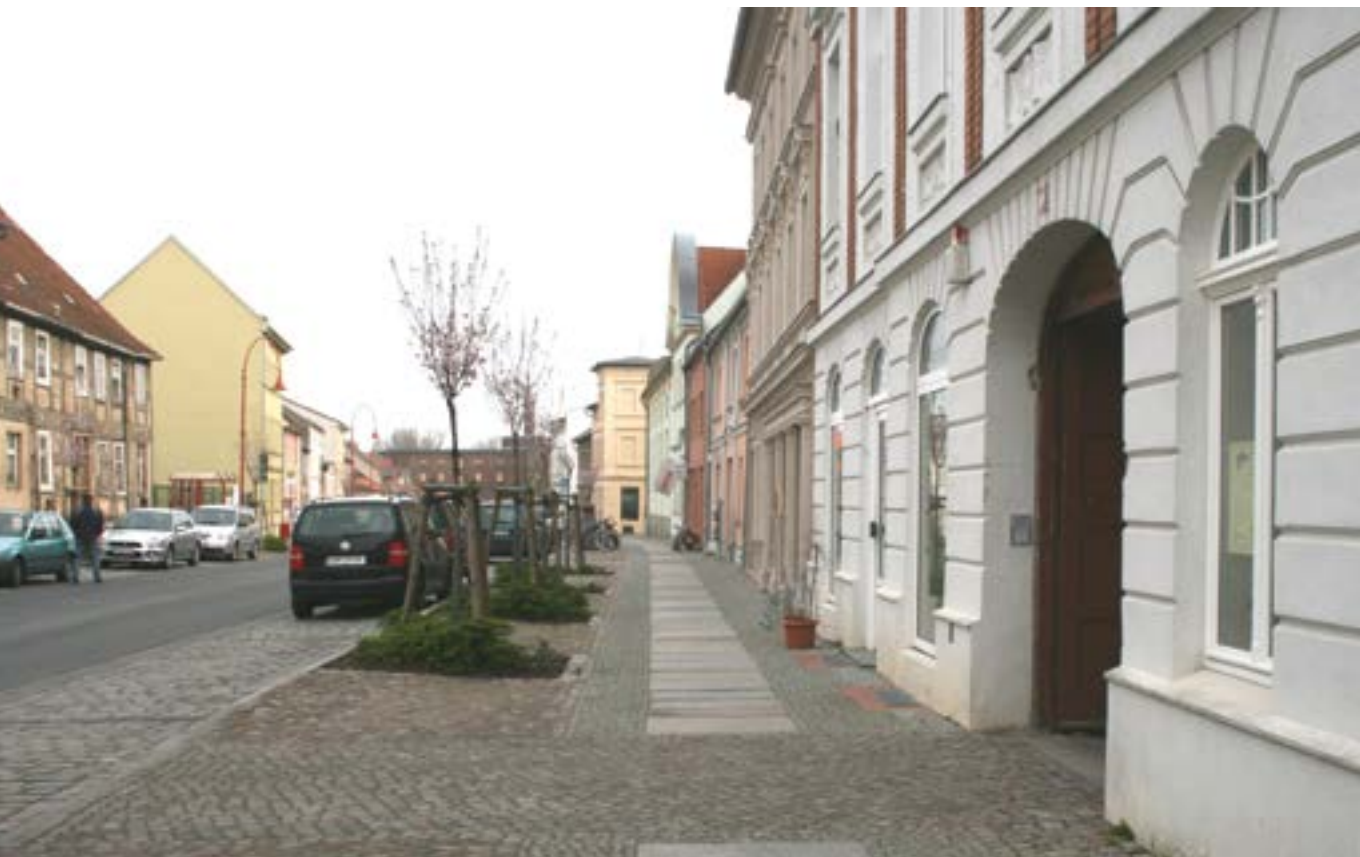
Abb. 3: Pflaster in der Berliner Straße, im Hintergrund die sanierungsbedürftige ehemalige Mälzerei (Foto: Stadtverwaltung Angermünde Frank Dorn)
