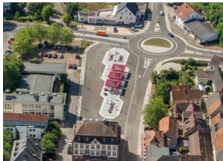
Abb. 2: Der neue Busbahnhof mit Kreisverkehr (Foto: Stadt Blieskastel)
