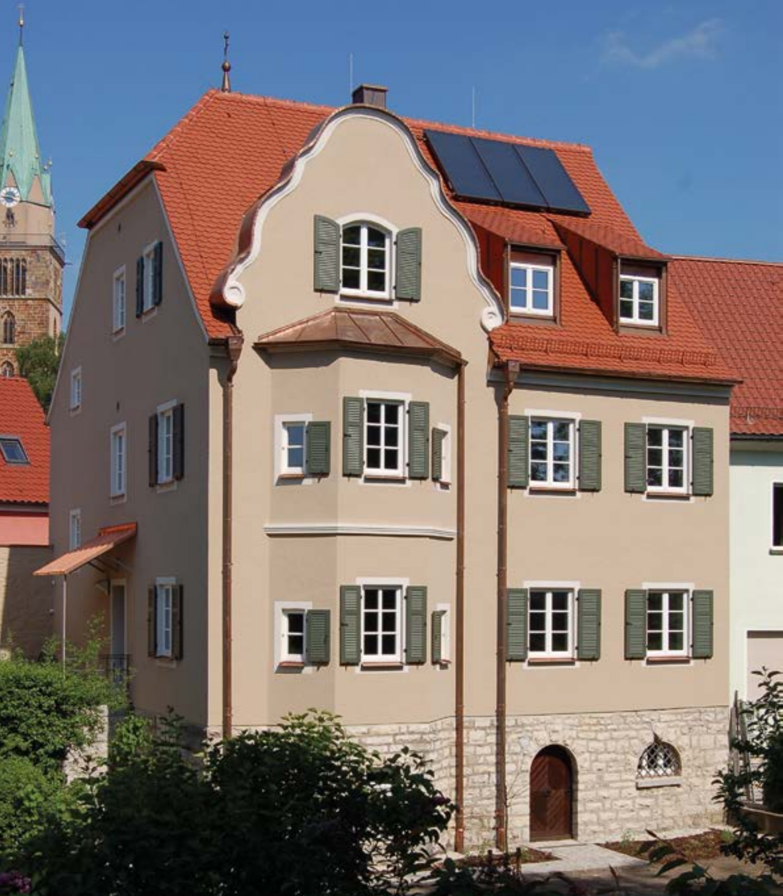
Abb. 1: Eine Altstadtvilla wurde saniert und energetisch aufgewertet. (Foto: Stadt Neumarkt i.d.OPf.)
