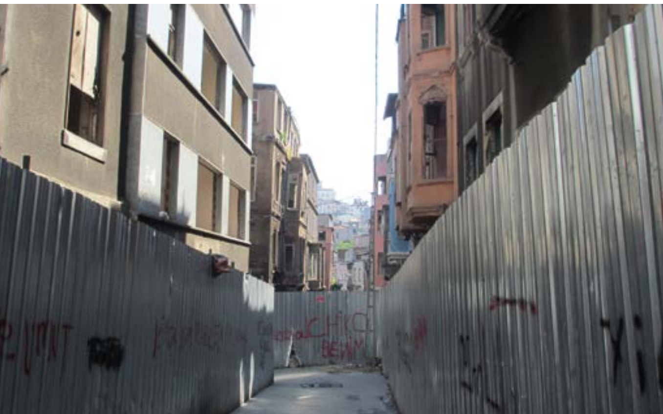
Abb. 5: Nach der Vertreibung der Anwohner aus Tarlaşağı wurden diese Stahlzäune errichtet um zu verhindern, dass die Bewohner zurückkehren können (Foto: Tobias Schäfer)
