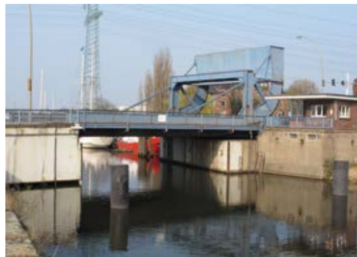
Abb. 9: Klappbrücke über den östlichen Bahnhofskanal aus den 1930er Jahren. (Foto: Schwarzkopf)
