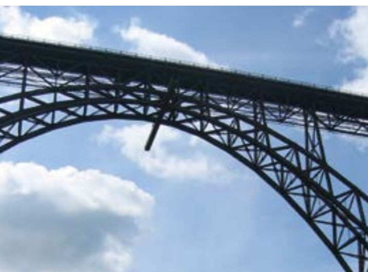
Abb. 4: Müngstener Brücke (Foto: Karl Jasper)
