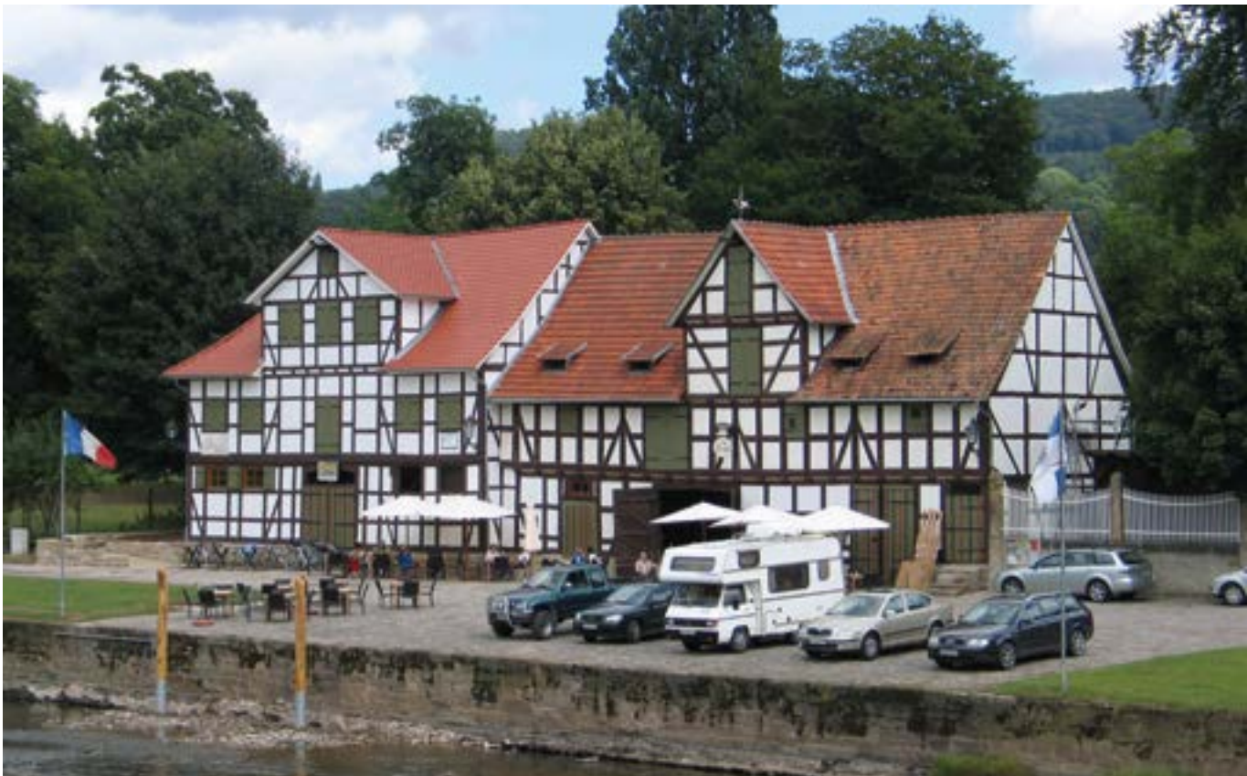
Abb. 4: Wanfried - Schlagd-Scheune (Foto: Landesamt für Denkmalpflege Hessen)
