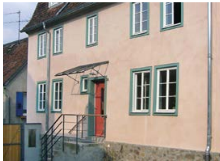
Abb. 2: Darmstadt - der Sandberghof nach Abschluss der Sanierung (Foto: Landesamt für Denkmalpflege Hessen)
