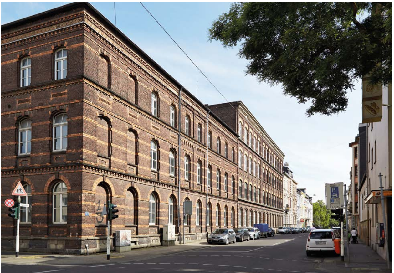
Das Denkmalensemble, in dem Wohnungen entstehen sollen. An der Ecke ist im Erdgeschoss ein „Nachbarschaftswohnzimmer“ geplant.
