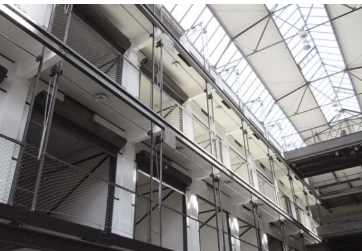
Lichthof der historischen Großgarage nach Sanierung
