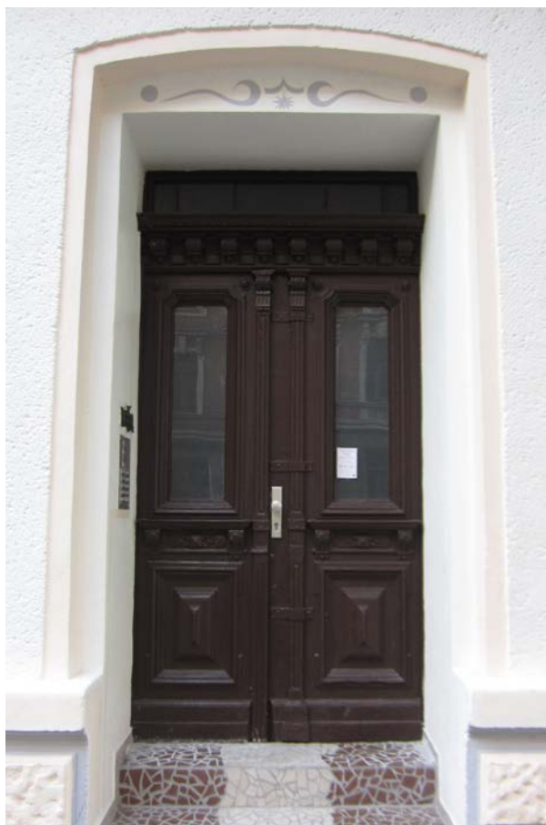
Selbstgelegtes Mosaik im Hauseingang
