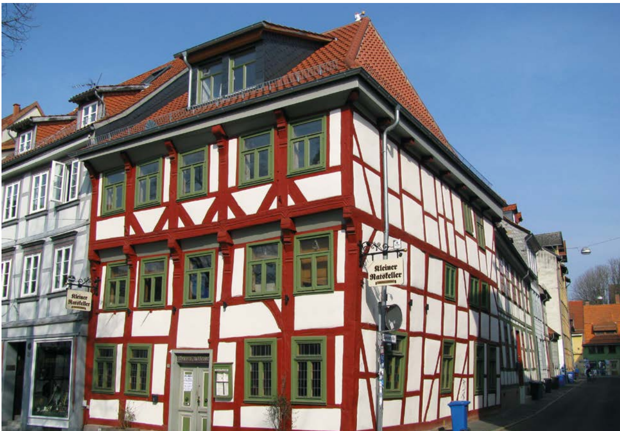
Kleiner Ratskeller nach der Sanierung
