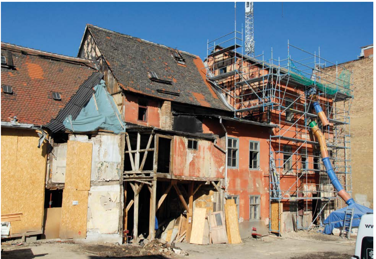
Rückseite der Gebäude in der Mittelstraße während der Sanierung
