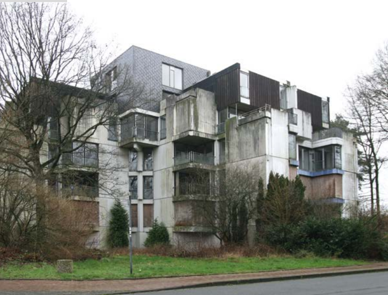
Damals eine Innovation im Wohnungsbau, heute ein Problemfall: Das Habiflex in Dorsten Berkenberg
