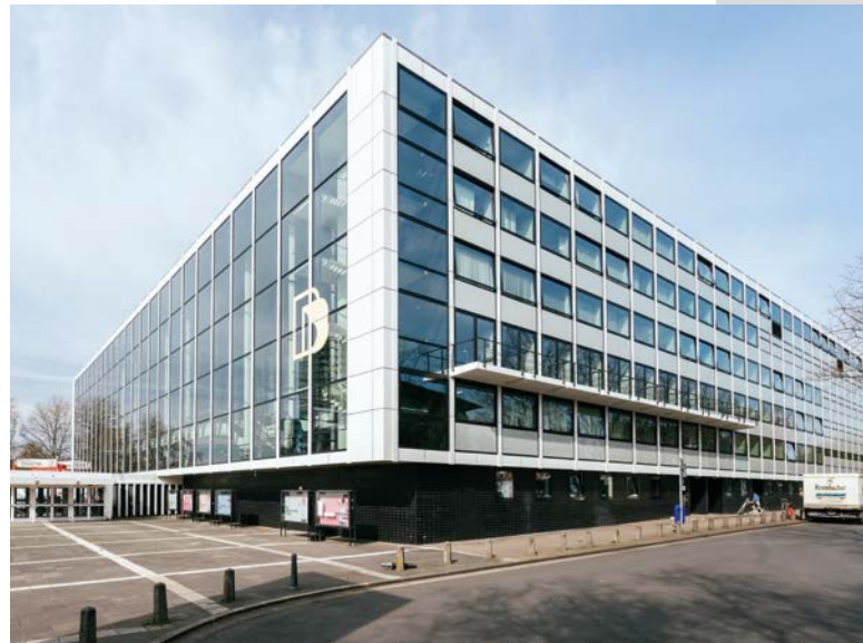
Ausgezeichnet als „Beispielhaftes Bauwerk der 1950er bis 1970er Jahre“: Das Musiktheater im Revier
