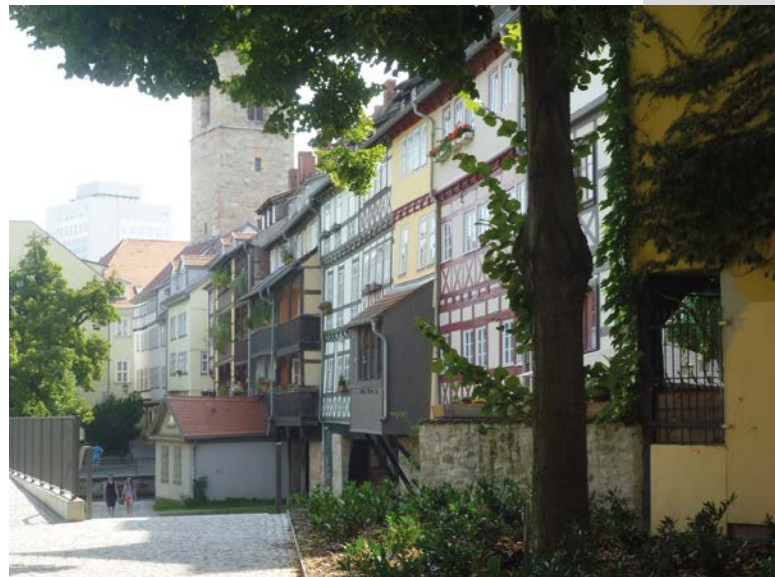
Die Krämerbrücke in Erfurt
