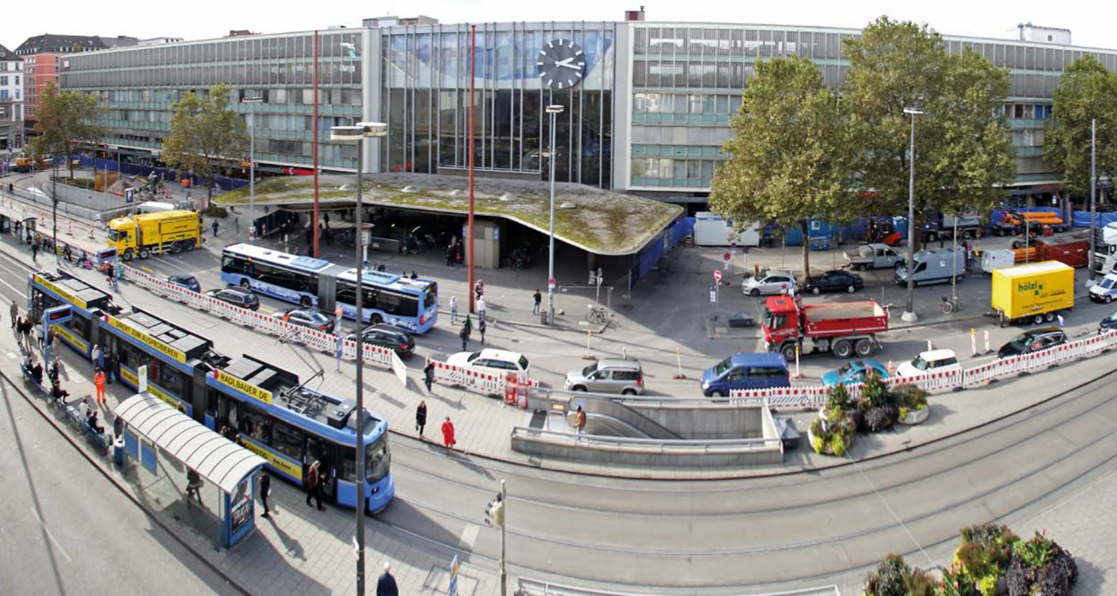
Hauptbahnhof im Bestand
