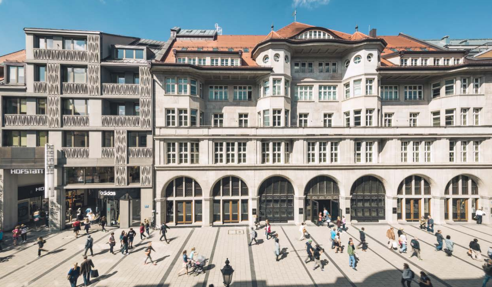
Hofstatt - Blocköffnung und neue Wege in der Innenstadt
