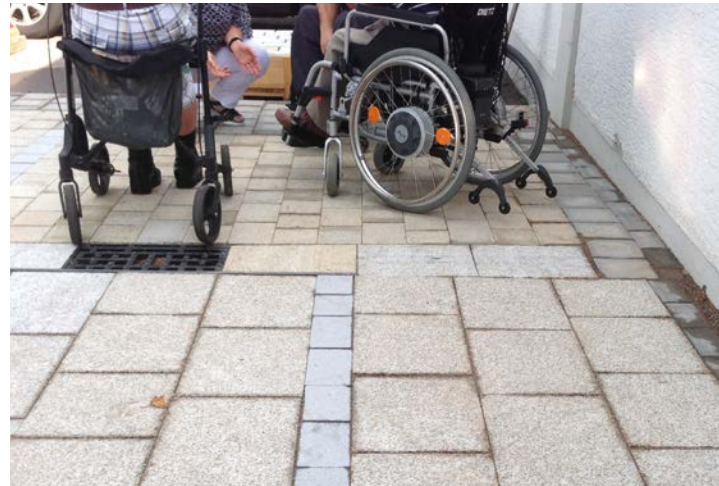
Musterfläche für die Theresienstraße: Rollstuhlfahrer testen das taktile Leitsystem auf Querbarkeit.
