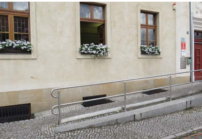
Barrierefreiheit an der Touristeninformation in Bad Belzig gemäß DIN-Norm 18040-1.
