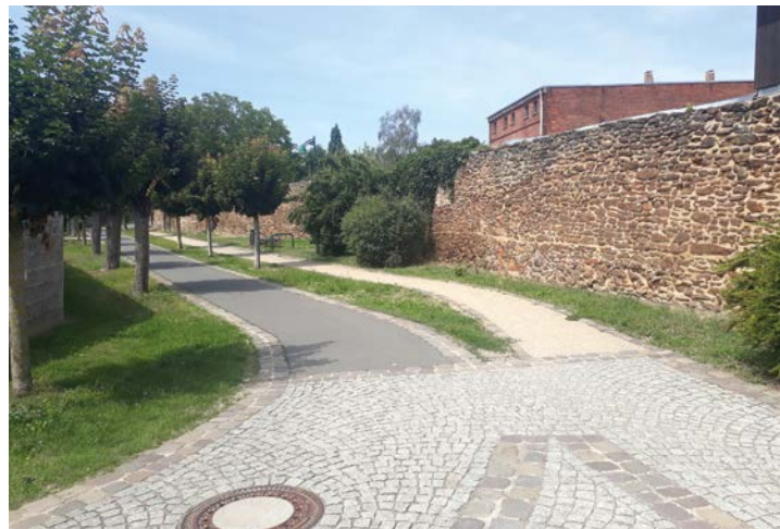
Ein Weg entlang der Stadtmauer erschließt die Innenstadt von Dahme.
