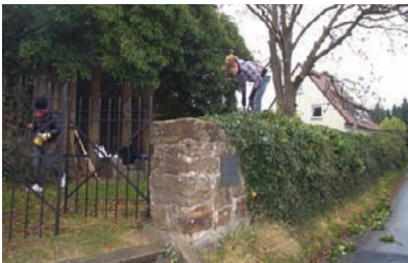
Abb. 3 | Grünpflegearbeiten unter fachlicher Anleitung an der Efeu-mauer des jüdischen Friedhofs in Hausberge (NRW) tragen zum Erhalt des historischen Mauerwerks bei.
