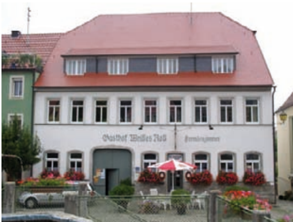
Abb. 8 | Fördermaßnahme im Kommunalen Förderprogramm der Stadt Aub
