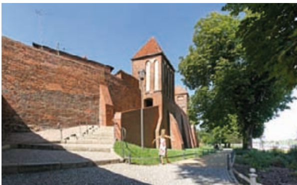
Abb. 3 | Sanierte Tangermünder Stadtmauern im Bereich der Putinnen-Türme
