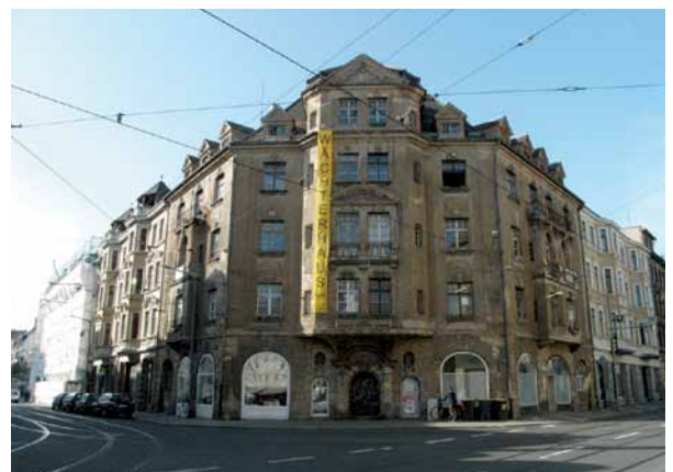
Abb. 4 | Demmeringstraße 21 als Wächterhaus
