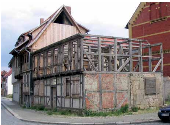
Abb. 5 | Schmale Straße 48 vor der Sanierung
