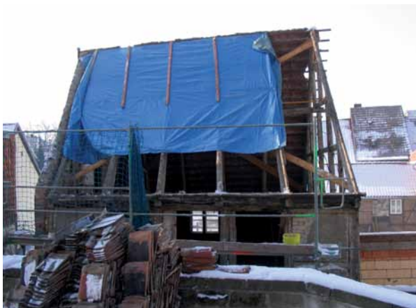
Abb. 9 | Wassertorstraße 29 vor der Sanierung
