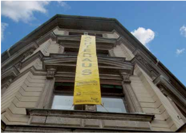
Abb. 2 | Fassade eines Wächterhauses mit Banner
