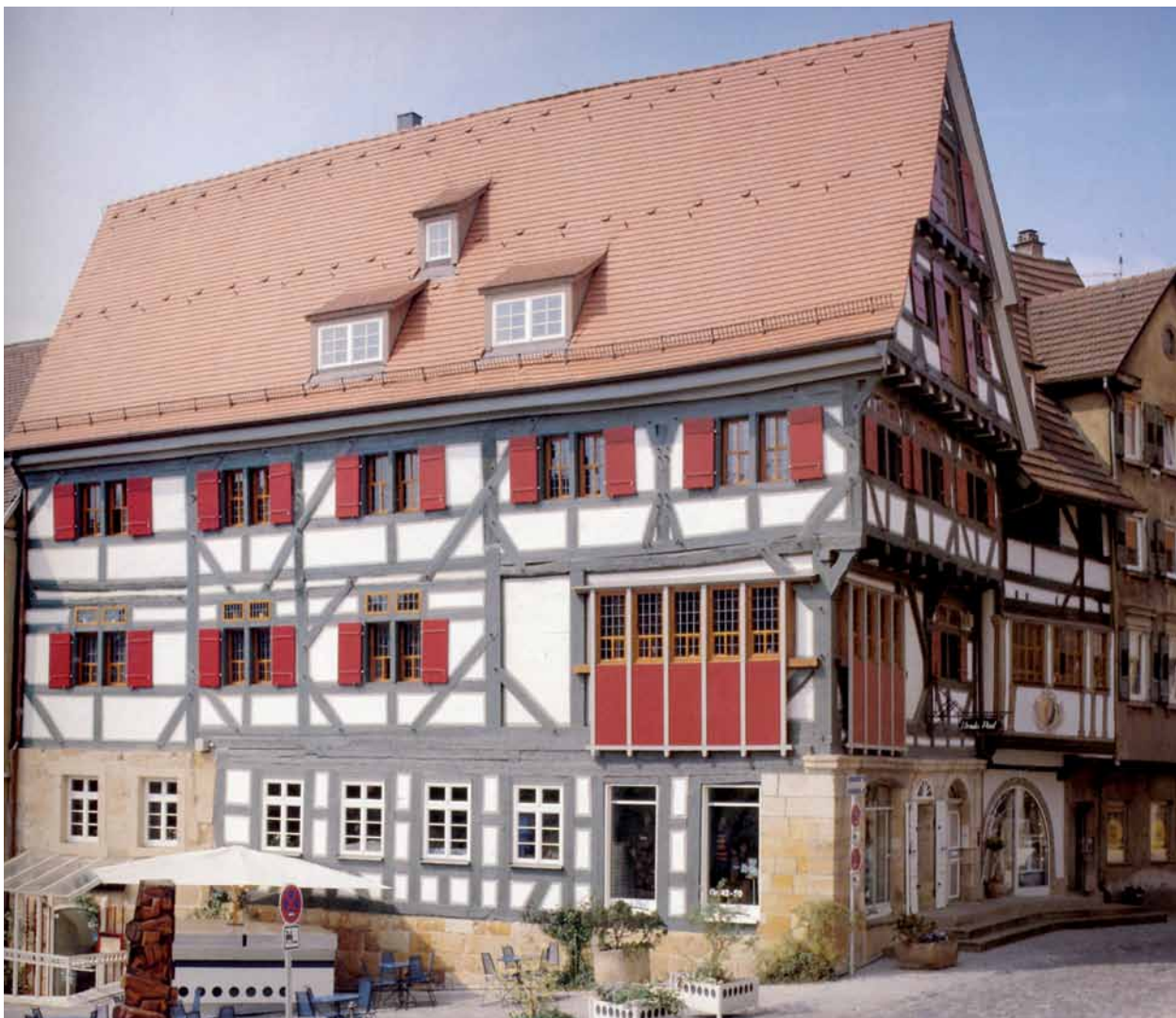
Abb. 6 | Sanierung Hafemarkt 8/10 von 1330/31
