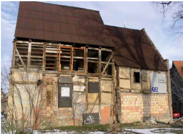
Abb. 3 | Schmale Straße 49-50 Rückseite vor der Sanierung
