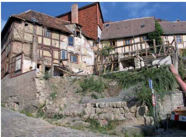
Abb. 7 | Wassertorstraße 5 vor der Sanierung
