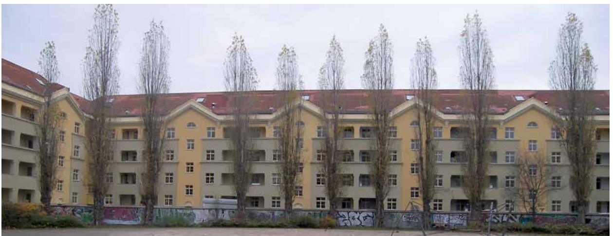
Abb. 8 | Sanierte Wohnanlage Zerbster Straße
