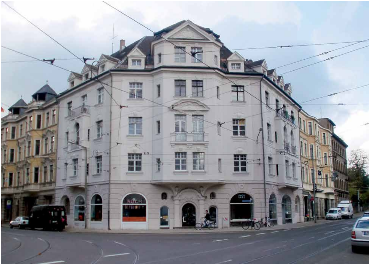
Abb. 5 | Demmeringstraße 21 nach der Fassadensanierung (2010)
