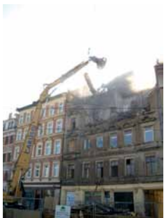
Abb. 4 | Abbruch Wurzener Straße 56
