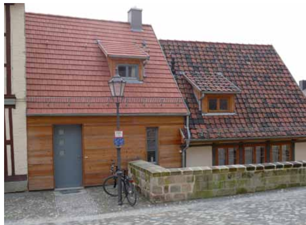
Abb. 10 | Wassertorstraße 29 nach der Sanierung
