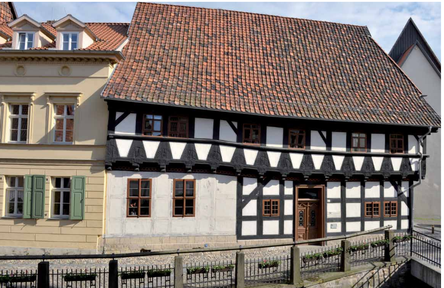
Abb. 11 | Word 3 nach der Sanierung
