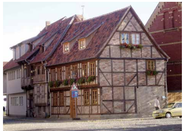
Abb. 6 | Schmale Straße 48 nach der Sanierung
