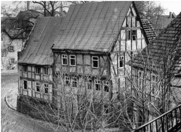
Abb. 1 | Schmale Straße 49-50 vor der Sanierung
