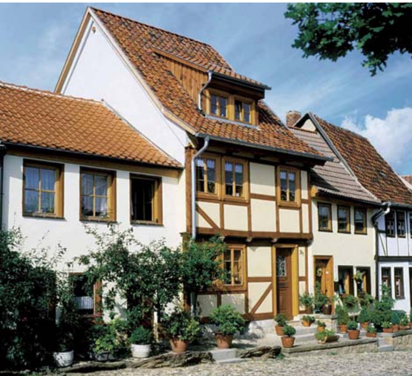
Abb. 13 | Münzenberg nach der Sanierung
