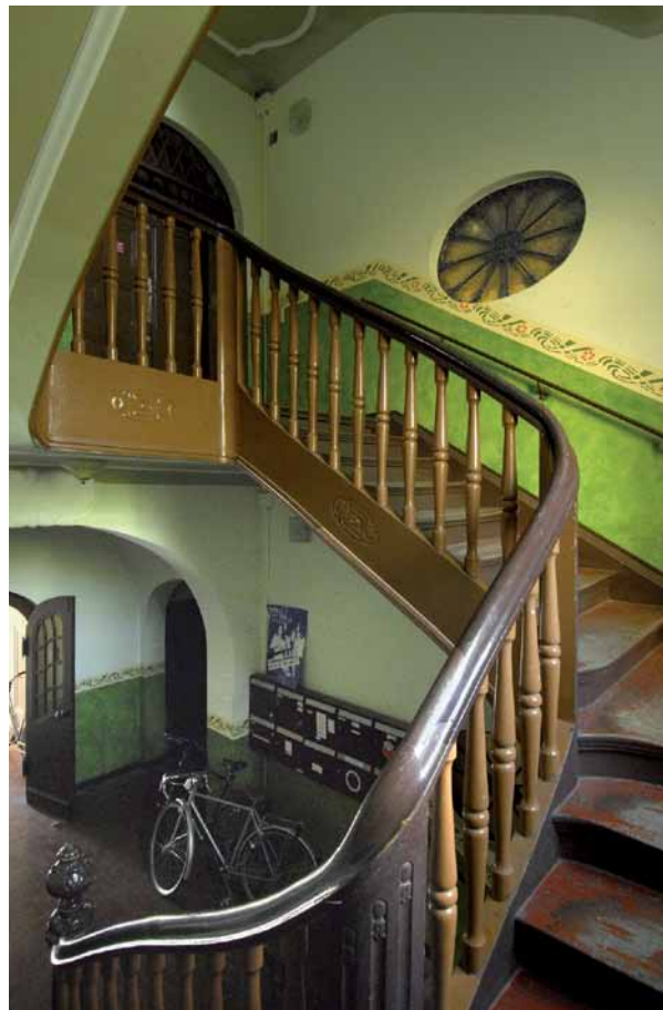
Abb. 3 | Treppenhaus in der Demmeringstraße 21
