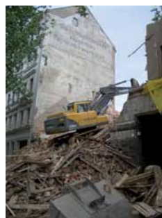
Abb. 6 | Abbruch Schönfelder Straße 6
