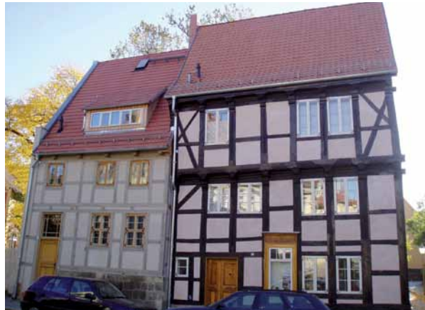
Abb. 2 | Schmale Straße 49-50 nach der Sanierung
