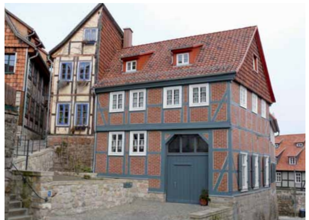
Abb. 8 | Wassertorstraße 5 nach der Sanierung
