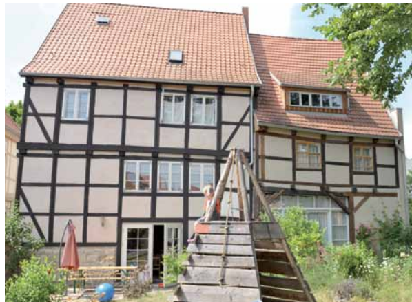
Abb. 4 | Schmale Straße 49-50 Rückseite nach der Sanierung
