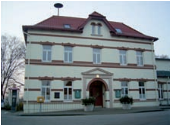
Abb. 3 | Im Jahre 2002 wurde das Ortsamt Hamburg Allermöhe generalsaniert und mit einer Wärmedämmung versehen. Zusätzlich wurde das alte Erscheinungsbild, die architektonische Gliederung der Fassade durch Klinker, mit Flachverblendern wiederhergestellt.
