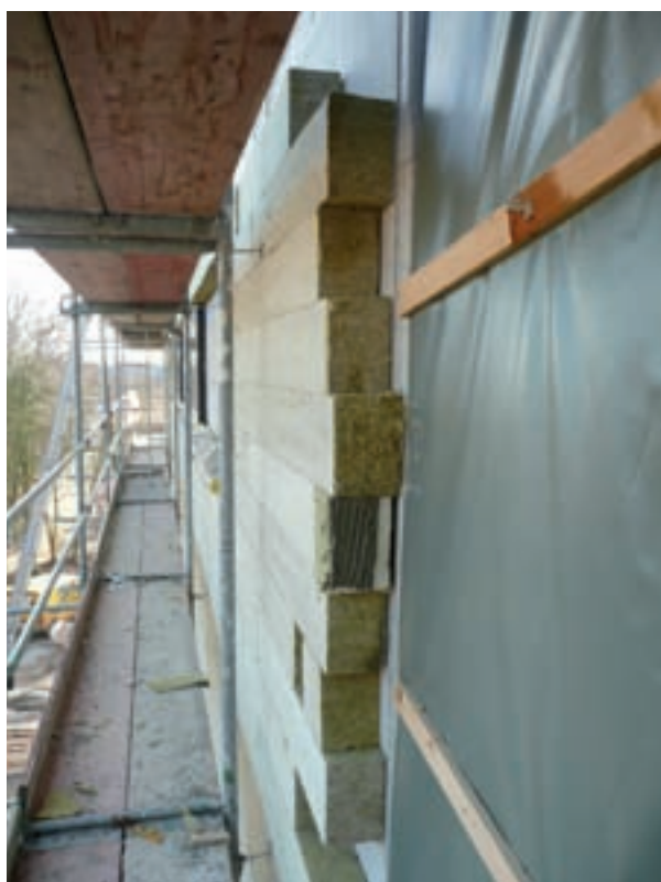
Abb. 11 | Fassadendämmung des Erweiterungsbaus
