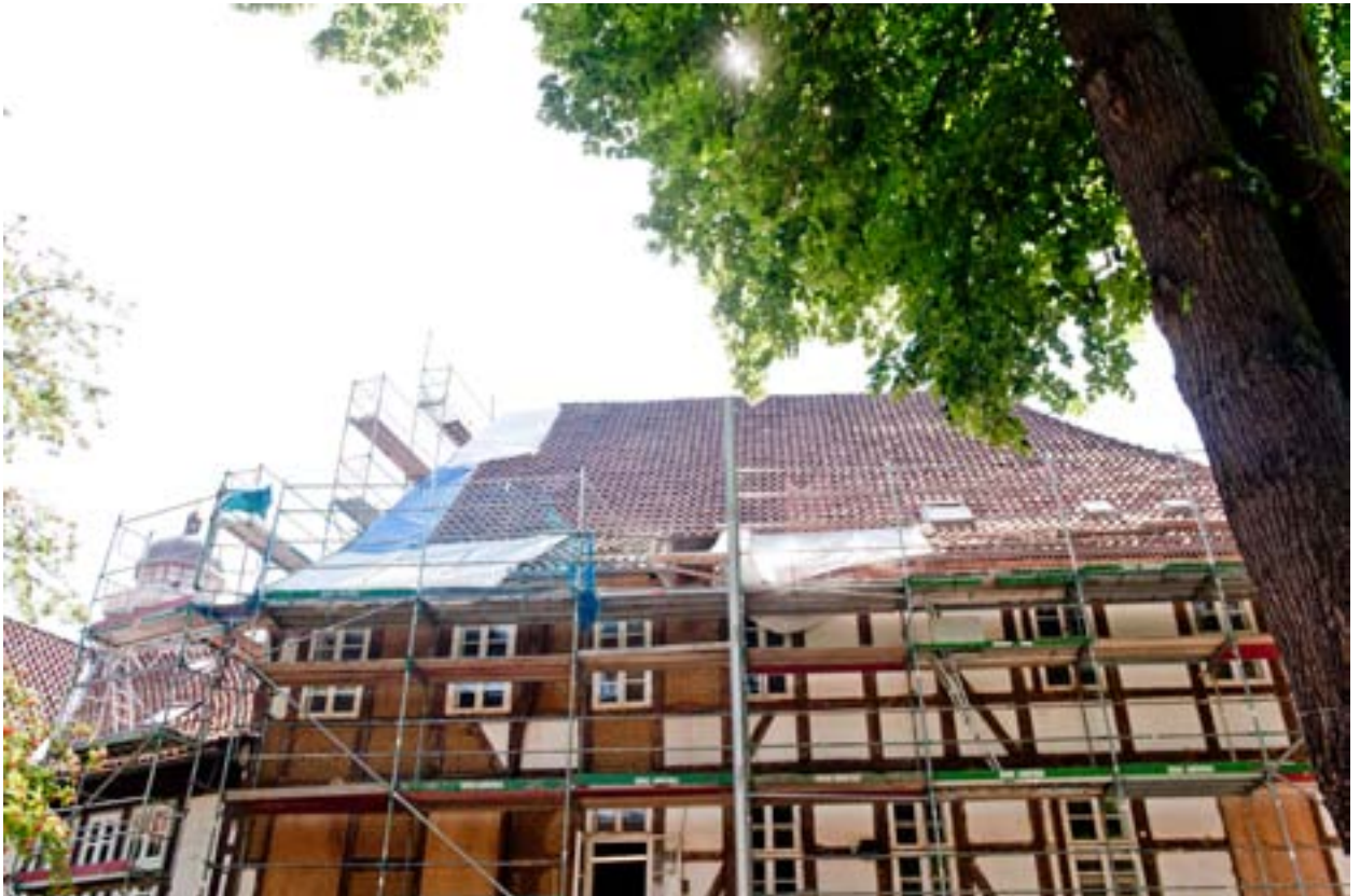
Abb. 1 | Städtisches Museum Göttingen während der Sanierung
