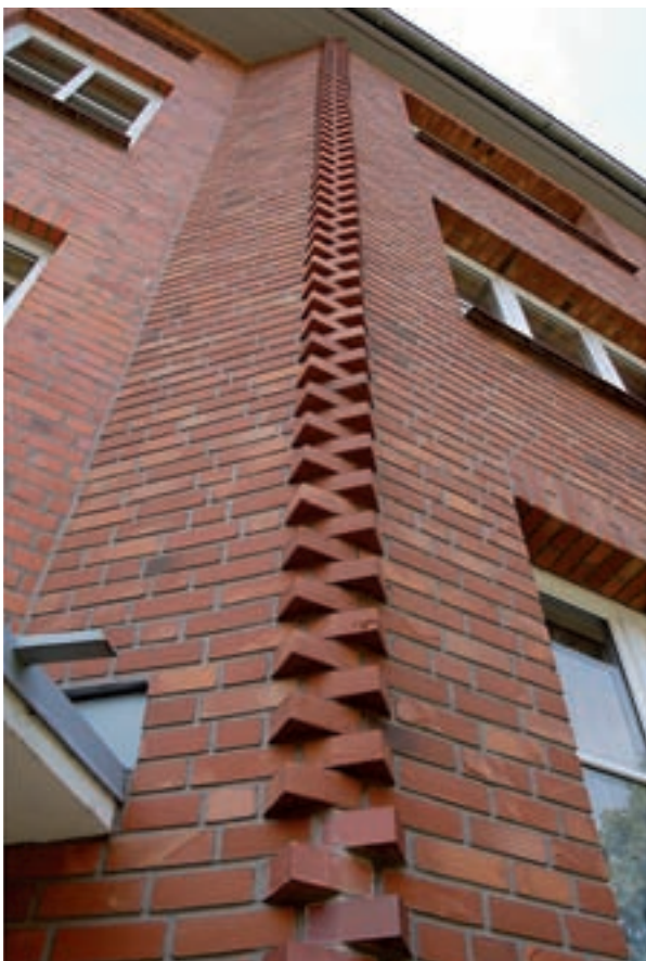
Abb. 4 | Ein Pilotprojekt in Hamburg Dulsberg. Durch Vorschädigungen war es unumgänglich, eine zweite wasserführende Schicht vor die verklinkerten Fassaden zu setzen. Eine der finanziell auch tragbaren Möglichkeiten war, ein WDVS-System anzubringen, das anschließend mit Klinkerimitatoptik an das ursprüngliche Erscheinungsbild angeglichen wurde.
