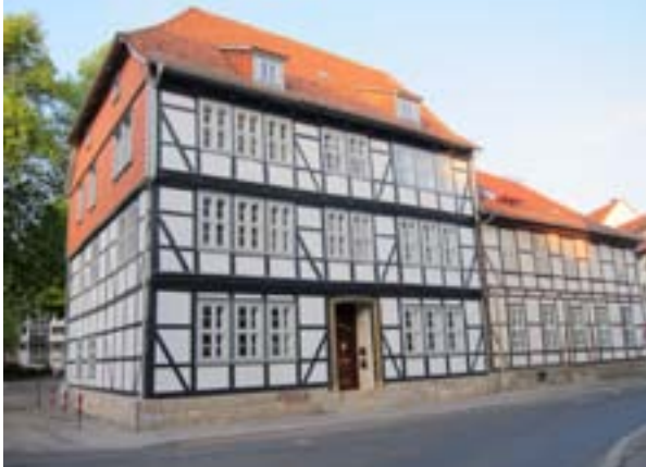
Abb. 6 | Alte Posthaltereie nach Fertigstellung
