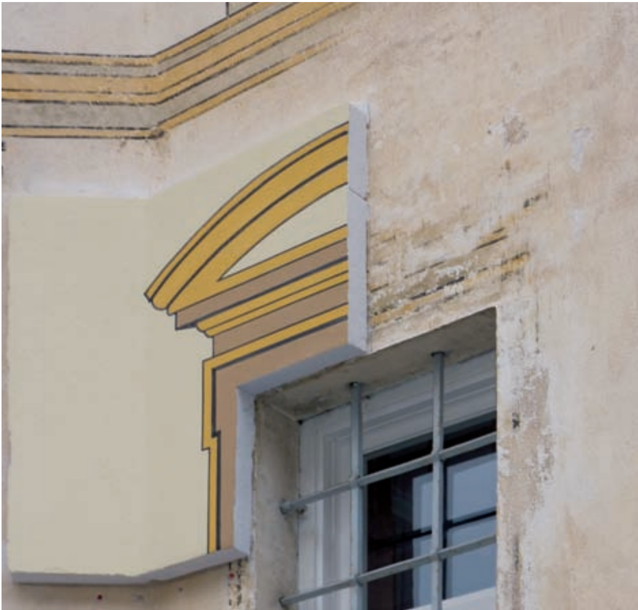
Abb. 1 | Probedämmung auf 40 cm Mauerwerk
