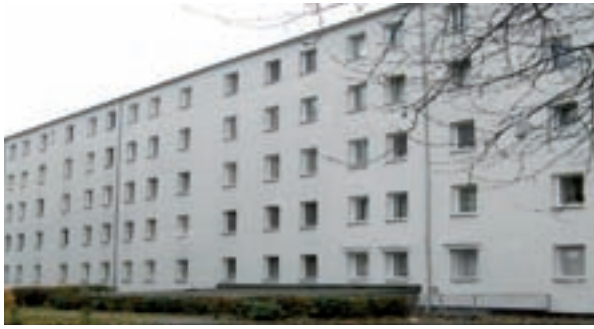
Abb. 3 | Hinterhof mit Wärmedämmverbundsystem
