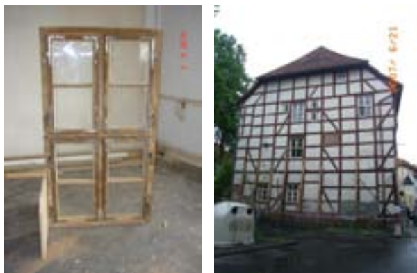
Abb. 4 | Aufgearbeitetes Bestandsfenster (links); abgestützte Westwand vor Durchführung der Sanierungsmaßnahme (rechts)
