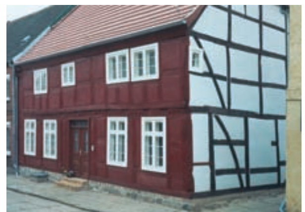
Abb. 20 | Sanierte Nord- und Westfassade
