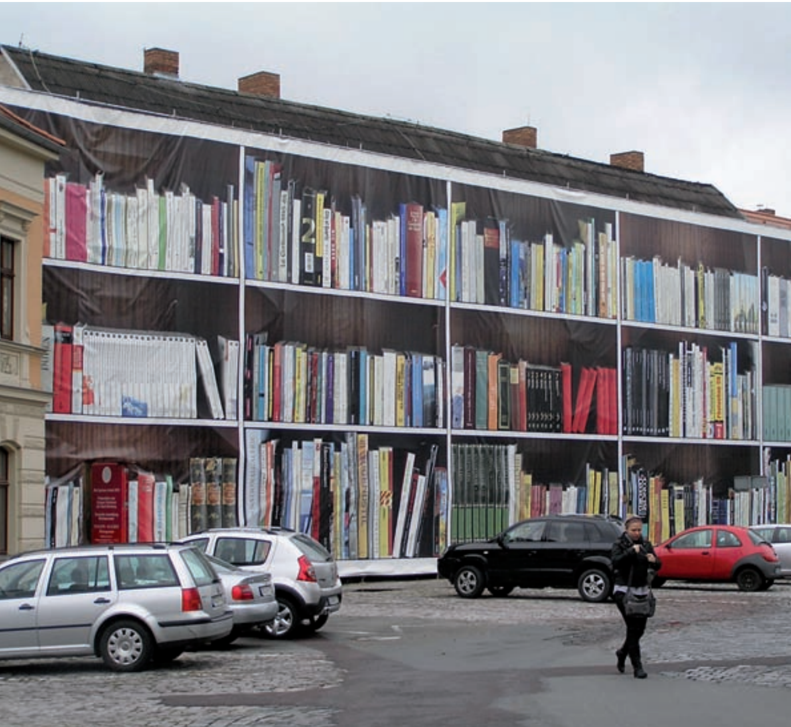
Sanierung Bibliothek in Bernburg, Sachsen-Anhalt | complan Kommunalberatung GmbH
