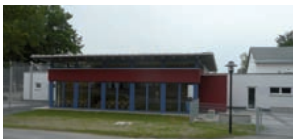
Abb. 12 | Neubau für eine zentrale Mittagsversorgung für mehrere Schulen im Stadtgebiet
