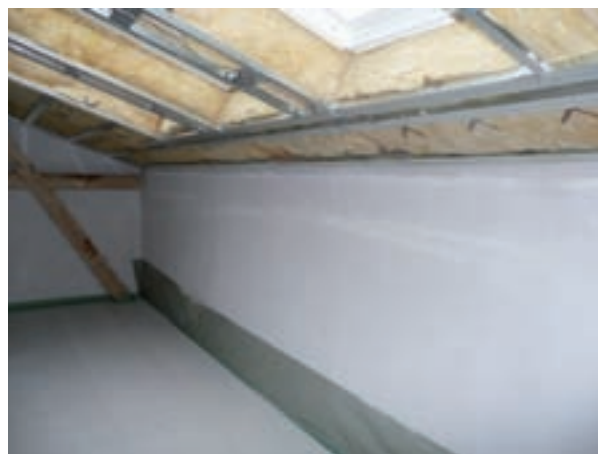
Abb. 7 | Innen- und Dachdämmung im historischen Schulgebäude
