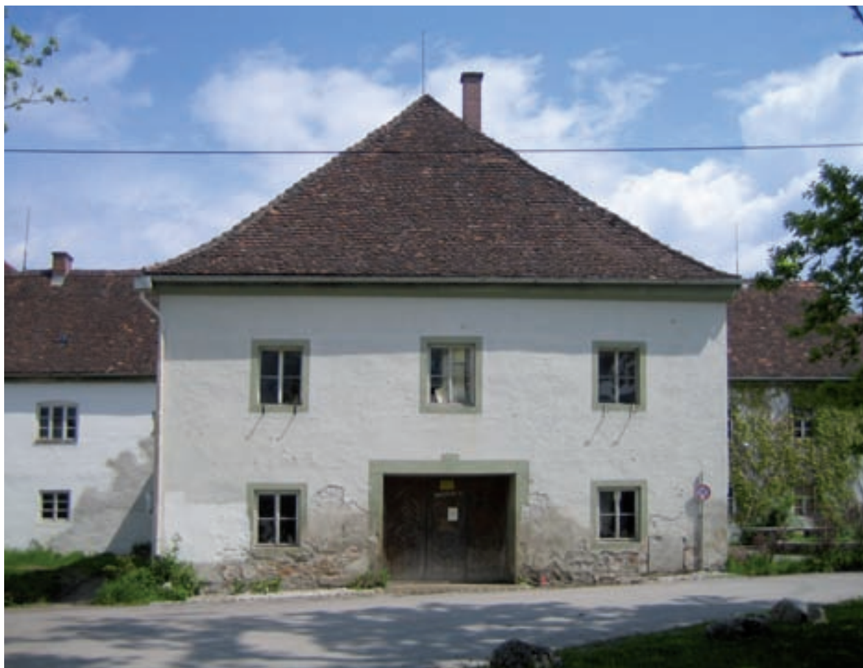
Abb. 1 | Alte Schäfllerei im Kloster Benediktbeuern, Sitz des Fraunhofer-Instituts für Bauphysik
