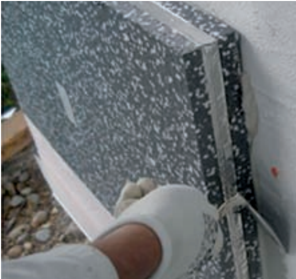
Abb. 1 | Vakuumisoliationspaneelen haben noch ihre Tücken, insbesondere bei der Verarbeitung. Hier ist noch großer Optimierungsaufwand nötig. Ebenso müssen die Herstellkosten noch deutlich reduziert werden. Derzeit liegt der Preis für 1 m 2 Dämmstoff bei ca. 150 € (ohne Verarbeitung)
