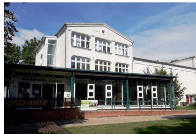
2016 Sanierung Multikulturelles Centrum Templin 7
