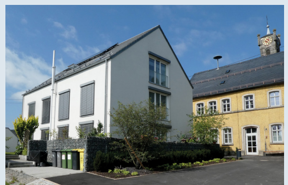
ARGE Rennsteig, Stadt Teuschnitz: Saniertes Wohngebäude (oben) und neu errichtetes Wohngebäude (unten)
