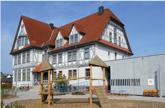
Schmalkalden: Kinderbildungszentrum nach der Sanierung
