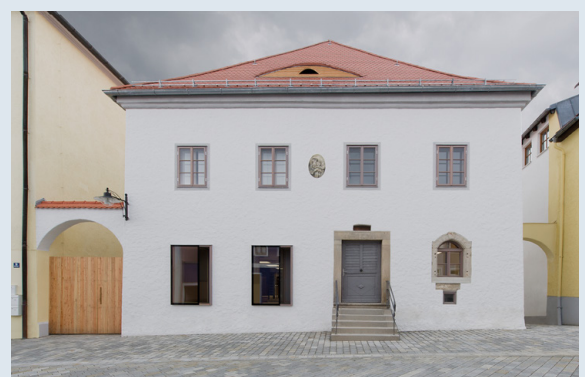
Ilzer Land, Markt Perlesreut: Die „Bauhütte“ vor und nach den Sanierungsmaßnahmen
