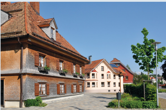
Markt Heimenkirch: Ehemaliger Gasthof vor den Umbauarbeiten (oben) und Ortskern (unten)
