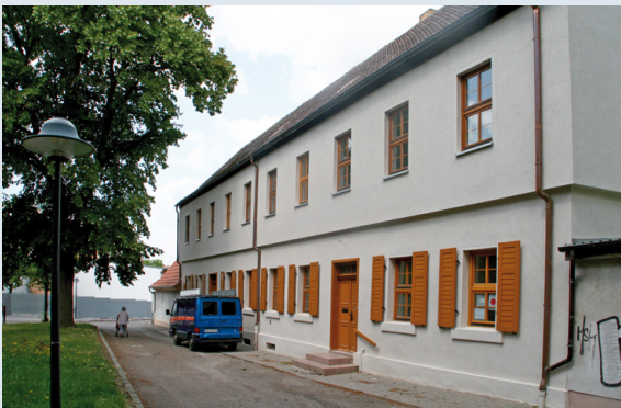
Zörbig: Schülerbeteiligungshaus vor und nach der Sanierung
