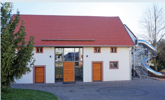
Thaleischweiler-Fröschen: „Spielscheune“ vor und nach den Umbaumaßnahmen
