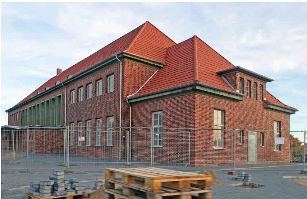
Bild 1: Der Bahnhof Wittstock ist nach dem Umbau Tourist-Information, Mobilitätszentrale und Ärztehaus (MVZ) © TU Kaiserslautern
