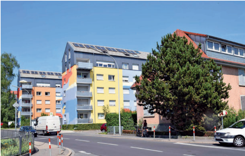
Sanierte Wohnhäuser Konstanz-Berchen
