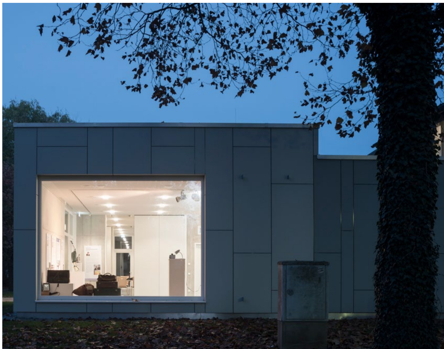
Abb. 72: Ansicht des Bürgertreffs in Dachau
