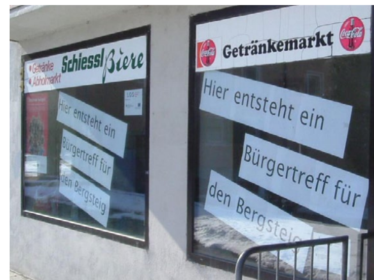
Abb. 23: Der vormalig leerstehende Getränkemarkt wurde durch ESF-Mittel und gemeinsam mit arbeitslosen Bewohnern des Quartiers zum Bürgertreff am Bergsteig „La BamBA“ umgebaut
