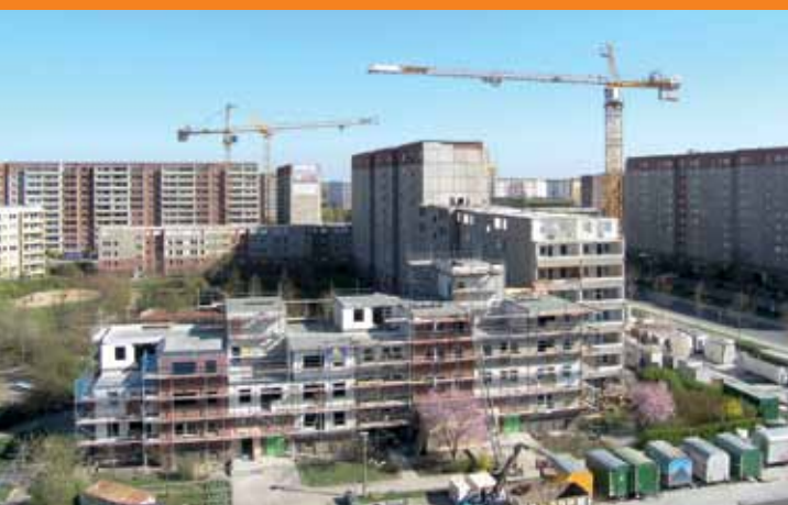
Elfgeschossige Plattenbauten im Rückbauprozess Quelle: degewo AG
