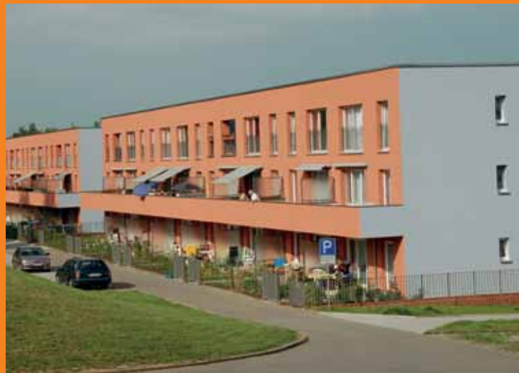
Plattenbau in der Südstadt von Leinefelde vor und nach der Sanierung (inkl. Teilrückbau) Quelle: Südstadtbüro Leinefelde
