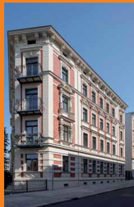
Sicherungsmittel bieten einen Anreiz, die Sanierung großer Eckgebäude anzugehen. Quelle: Kai-Uwe Schulte-Brunert
