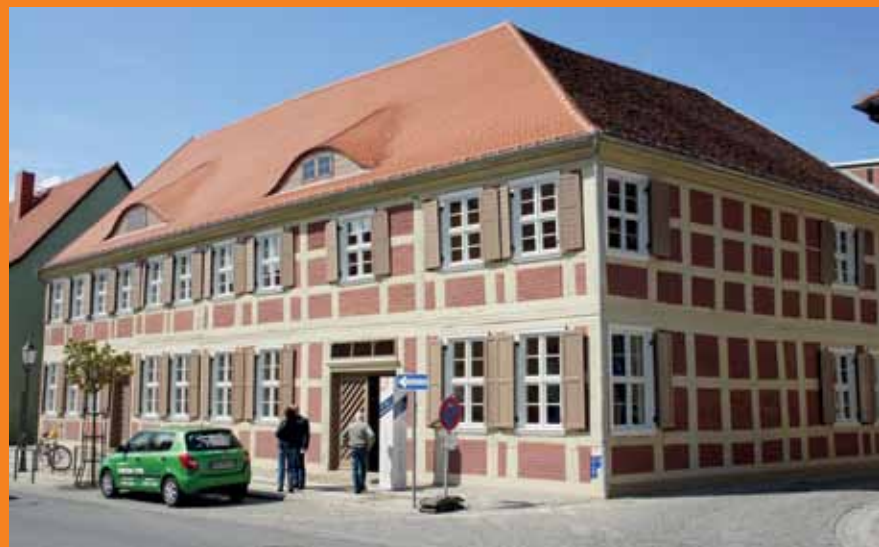
Die Sanierung dieses Fachwerkgebäudes ermöglichte den Umzug der Bibliothek in die Innenstadt von Wittstock. Quelle: B.B.S.M. GmbH, Potsdam
