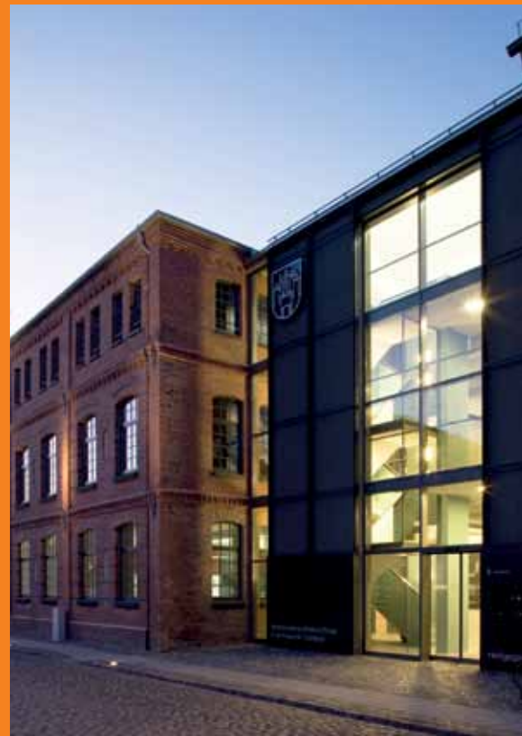
Umbau einer Gewerbebrache zum zentralen Verwaltungsstandort in der Innenstadt Quelle: Kannenberg Architekten BDA, Cordia Schlegelmilch, Wittstock
