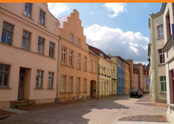
Viele historische Gebäude in der Altstadt von Güstrow sind heute saniert. Quelle: BIG Städtebau GmbH, Frieder Blickle
