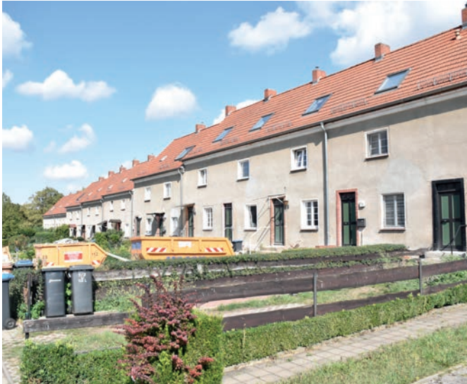
Große Teile der Gartenstadt werden zurzeit saniert
