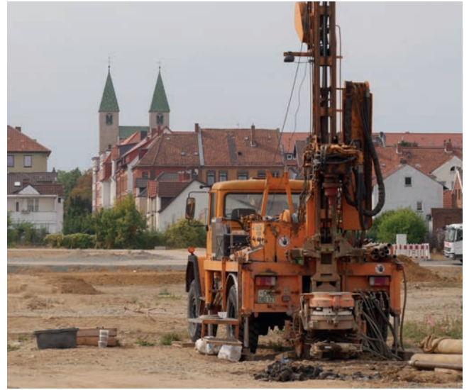
Die Bauarbeiten auf dem Gelände sind in vollem Gange
