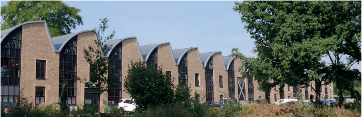
Die Paschenhalle wurde von einem Industriegebäude in ein hochmodernes Zentrum für Gewerbe umgewandelt
