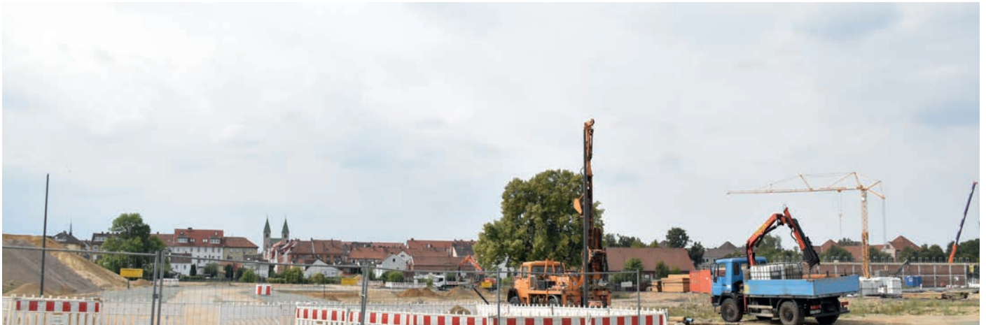
Ausblick von der – sich im Umbau befindlichen – ehemaligen Mackensenkaserne ins Zentrum von Hildesheim
