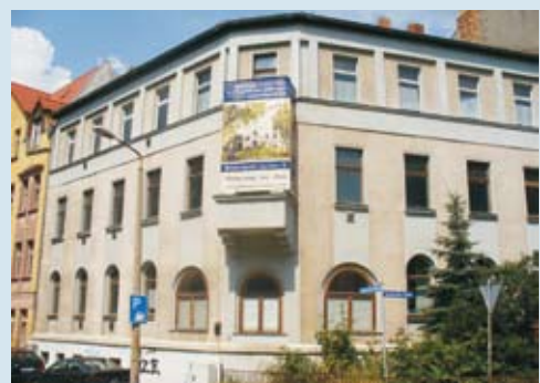
Abbildungen 3.4 und 3.5: Unsaniertes Altbaubestand in Halle-Glaucha
