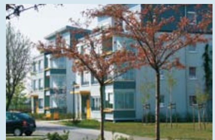
Abbildungen 5.10 und 5.11: oben: Für den Abriss vorbereitete Häuserzeile im Stadtteil Am Waldrand unten: Teilrückbau im Külzviertel
