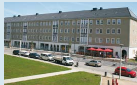
Abbildungen 5.15 und 5.16: Die Wohnanlage „Am Bergmann“ in Sangerhausen nach der Sanierung
