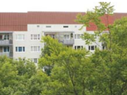
Abbildung 5.21: Stilllegung von Ober- geschossen in Weißenfels
