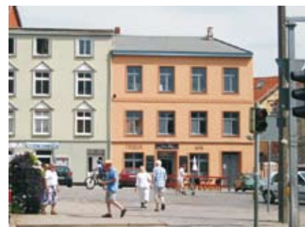
Abbildungen 1.1 und 1.2: Innerstädtischer Altbau in Stralsund vor und nach der Sanierung, 2006 und 2010
