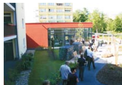
Abbildungen 5.2 und 5.3: In der Wohnsiedlung Süd-West in Sangerhausen entstanden im Rahmen eines Neubauvorhabens 26 barrierefreie Wohnungen sowie eine Begegnungsstätte.
