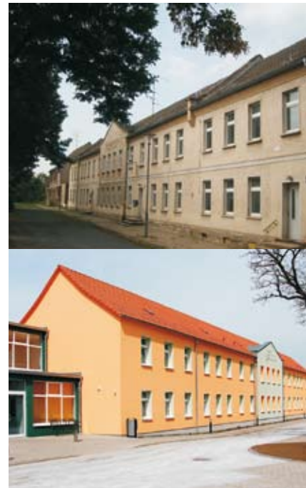
Abbildungen 4.2a und b: Umbau des historischen Thimannstifts zum Senioren- wohnheim durch die Städtische Wohnungsbau GmbH Schönebeck
