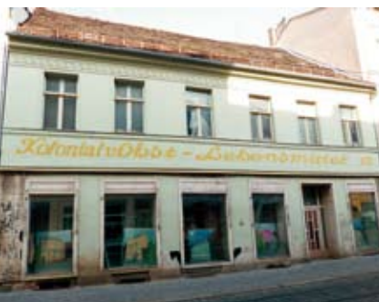
Abbildung 4.32: Sicherungsmaßnahmen und Zwischennutzung in Brandenburg an der Havel
