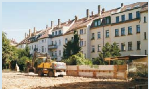
Abbildungen 4.39 und 4.40: Blockinnenbereich im Bülowviertel vor (oben) und nach dem Abriss von leerstehenden Hinterhäusern
