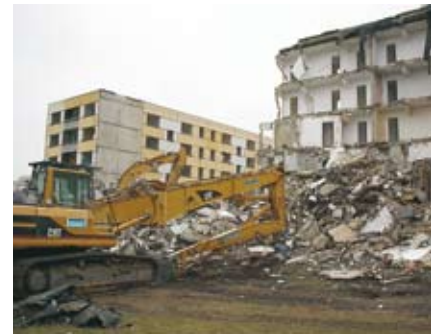
Abbildung 2.7: Seit 2002 wurde rund jede zehnte Plattenbauwohnung in Ostdeutschland abgerissen
