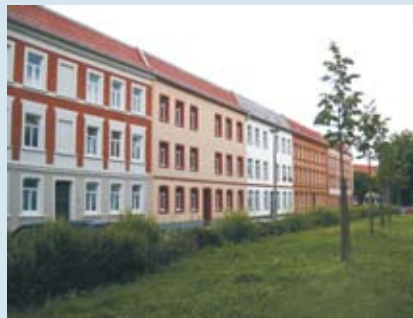
Abbildungen 4.22 und 4.23: Der Finckehof nach der Sanierung
