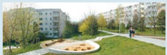
Abbildungen 5.17 und 5.18: oben: Rückbau im Erfurter Stadtteil Herrenberg unten: Sanierungs- und Aufwertungsmaßnahmen
