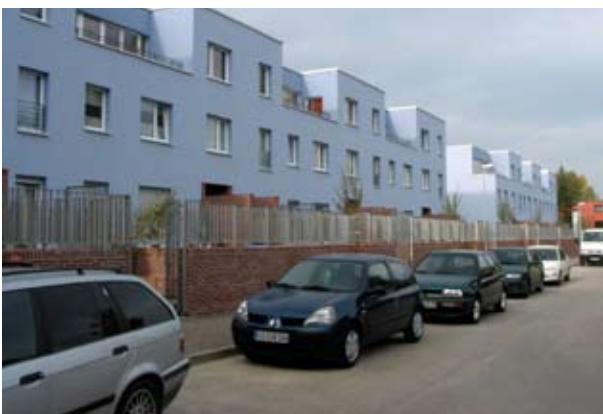
Teilrückbau und Umbau von Plattenbauten in Leinefelde
