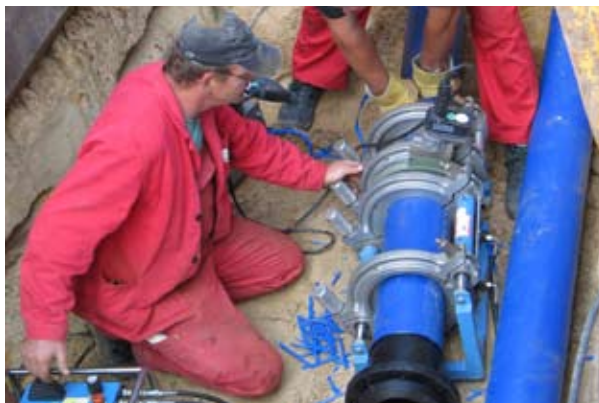
Leitungsanpassung in Hoyerswerda-Neustadt
