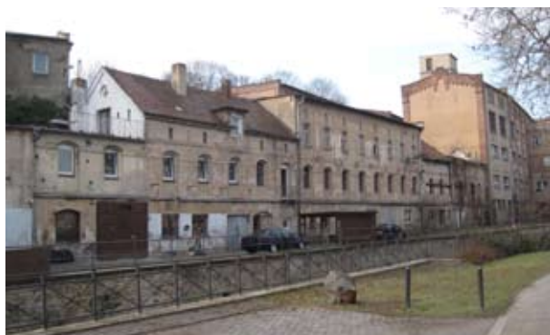
Im industriell geprägten Zeitz stellt die Sanierung und Nutzung ehemaliger Fabrikgebäude eine große Herausforderung dar.
