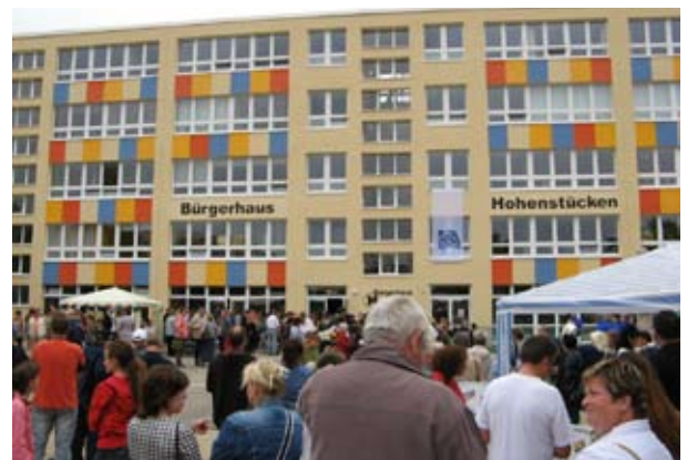
Umbau und Umnutzung einer ehemaligen Schule zu einem Bürgerhaus mit Angeboten für Jung und Alt in Brandenburg an der Havel
