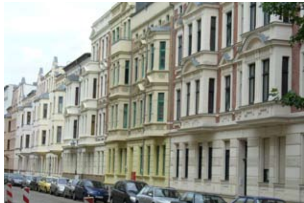
Ein großer Teil der Gründerzeitbestände in Magdeburg-Stadtfeld wurde in den 1990er Jahren saniert.
