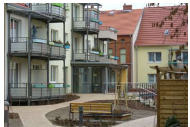
Vom kommunalen Wohnungsunternehmen saniertes Altbauensemble in Wittstock
