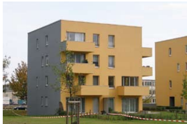
Teilrückbau von Plattenbauten zu Stadtvillen in Leinefelde-Worbis: Realisierungswettbewerbe sicherten eine hohe Qualität der Umbauten.
