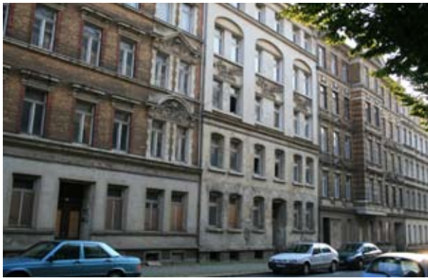
Viele Gründerzeitgebäude profitierten in den 1990er Jahren kaum vom Sanierungsboom.
