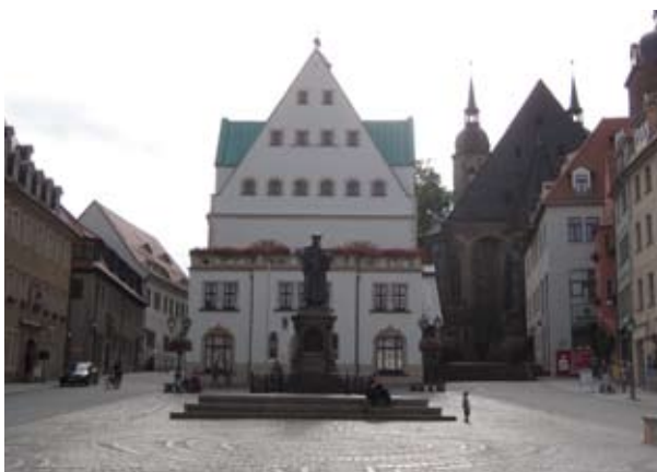
Saniertes Einzeldenkmal in der Lutherstadt Eisleben
