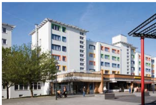
Seniorenpflegeheim und altengerechte Wohnanlage an den Ringkolonnaden nach Teilrückbau eines elfgeschossigen Wohngebäudes
