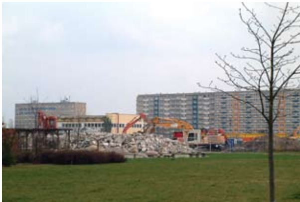
Flächenhafter Abriss von Wohngebäuden in Halle-Silberhöhe
