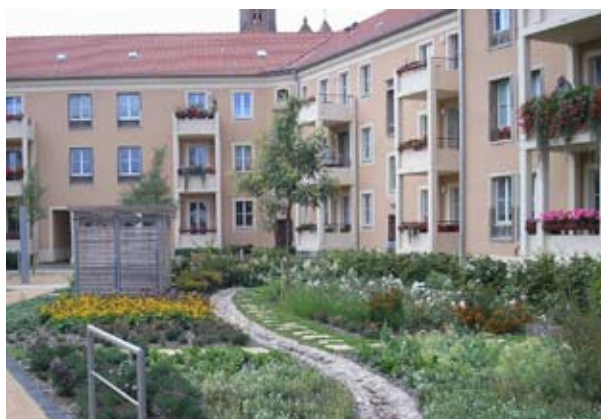
Brandenburg an der Havel: Unterstützt durch Aufwertungsmittel aus dem Programm Stadtumbau Ost hat die Wohnungsbaugesellschaft das Klosterquartier aus den 1950/60er Jahren denkmalgerecht saniert.
