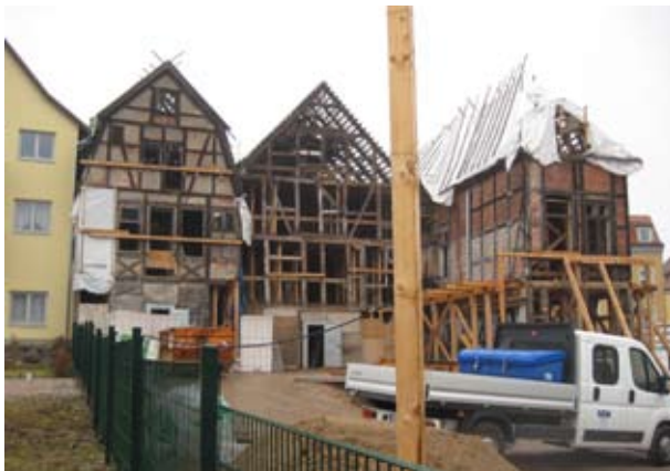
Aufwendige, denkmalgerechte Sanierung von drei nebeneinander liegenden Fachwerkhäusern
