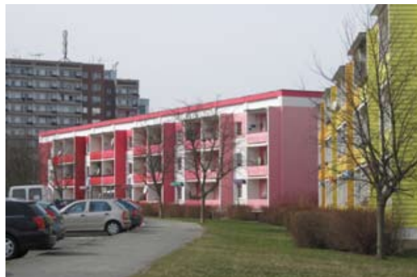
Einfacher Teilrückbau durch Geschossreduzierung
