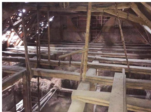
Foto: Dachstuhl der ehemaligen Scheune vor Umbau zur Kita (Quelle: Gerlach Architekten, Fritzlar)
