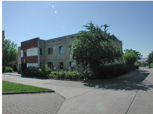
Foto: Seitenansicht der Kita Bummi vor Maßnahmenbeginn (Quelle: Stadt Artern)
