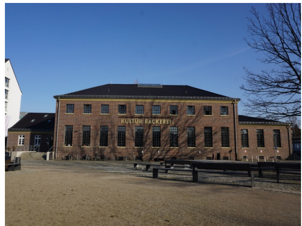
Foto: KulturBäckerei, nach Maßnahmenumsetzung (Quelle: steg NRW)
