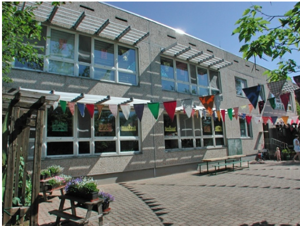
Foto: Rückseite der Kita Bummi vor Maßnahmenbeginn (Quelle: Stadt Artern)
