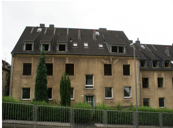
Foto: Teil der abgerissenen GEWAG-Gebäude (Quelle: Stadt Remscheid)
