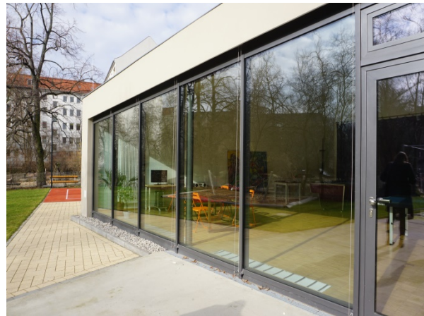
Foto: Außenbereich und Multifunktionsraum im Neubau des Jugendclubs (Quelle: steg NRW)
