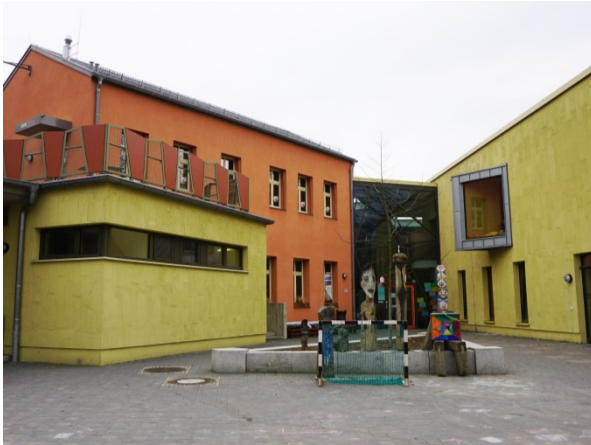
Foto: Familienzentrum am Spreeufer mit angebauter Kita (Quelle: steg NRW)
