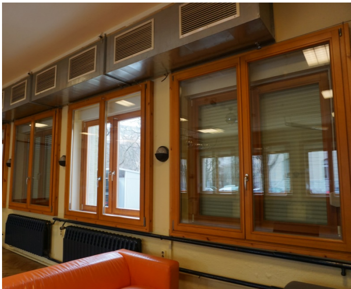
Foto: Sanierung und akustische Isolierung im Bestand des Jugendclubs (Quelle: steg NRW)
