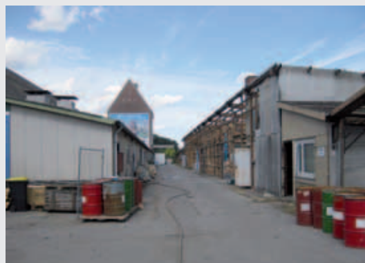
Ungenutzte Gewerbebauten vor dem Abriss
