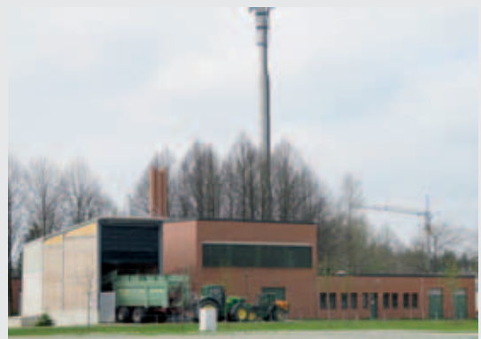
Umgerüstetes Blockheizkraftwerk auf dem Kasernenareal
