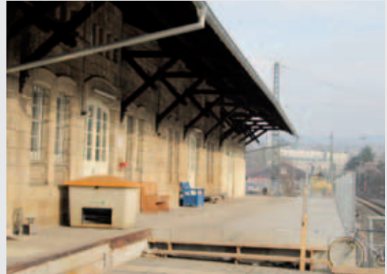
Güterhalle des Bahnhofs Melsungen
