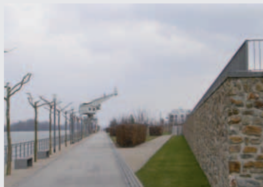
Neue Uferpromenade am Rhein
