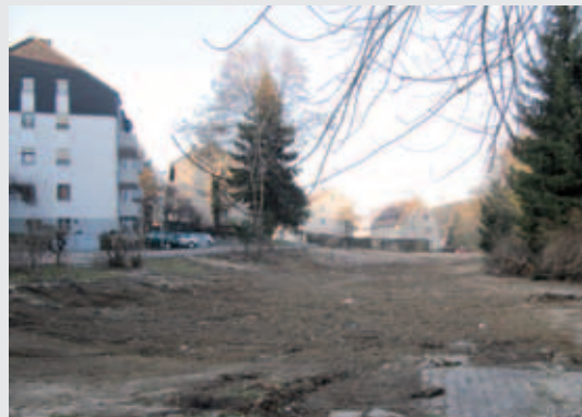
Fläche nach Abriss der Wohngebäude
