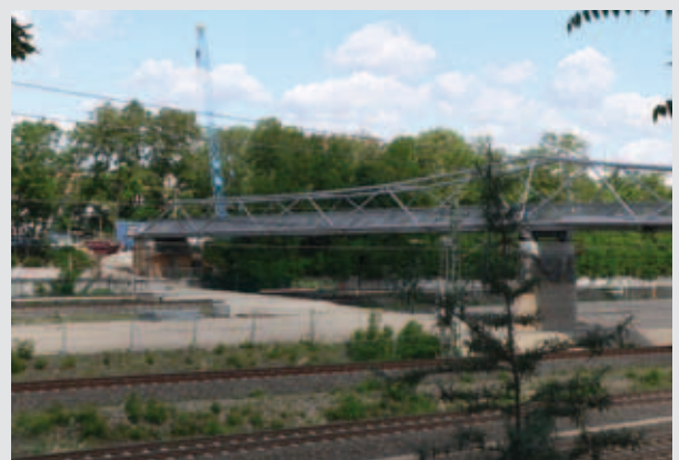
Neue Fußgängerbrücke über die Bahn
