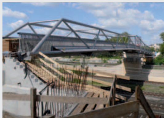
Neubau der Bahnquerung
