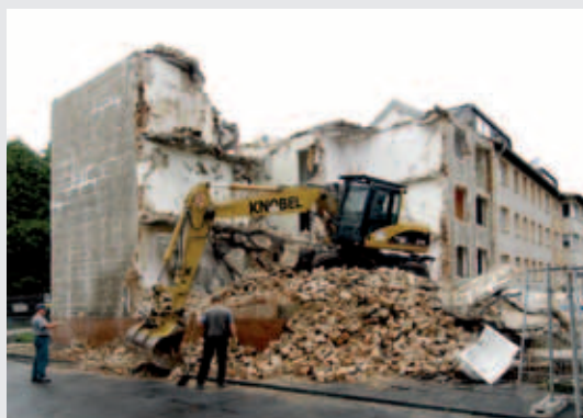
Abriss von Wohngebäuden der gbg
