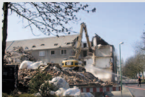
Abriss alter Bebauung macht Platz für Neues
