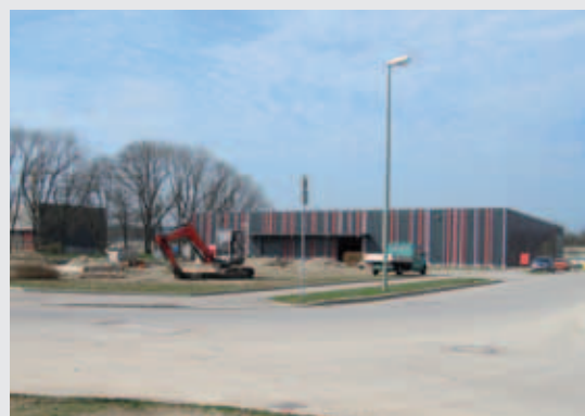
Gewerbeneubau im Gebiet
