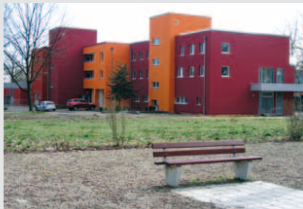
Modernisierter Bestand nach Abriss und Rückbau
