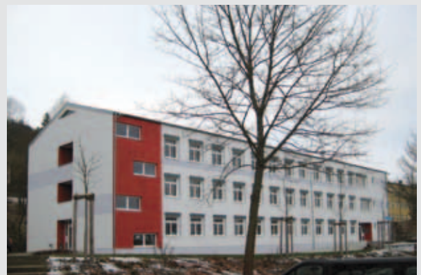
Kasernengebäude nach Sanierung und Umbau
