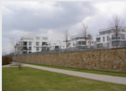
Neues Wohnquartier am Rhein: Gartenstadt
