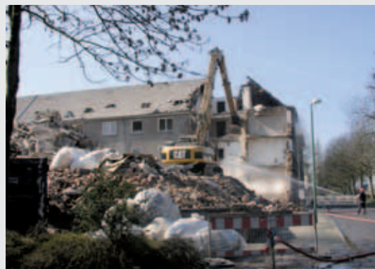
Rückbau der Bestände der Allbau AG
