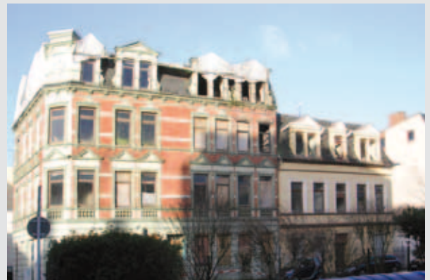
Schrottimmobilien im Quartier
