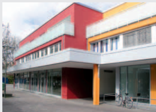
Umgebaute Ladenzeile nach Rückbau
