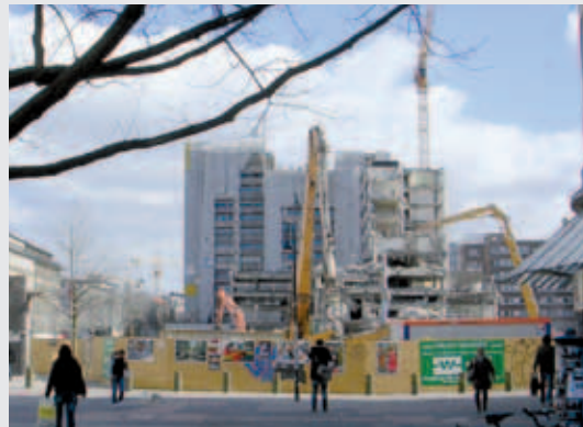
Abriss Frappant-Komplex Große Bergstraße
