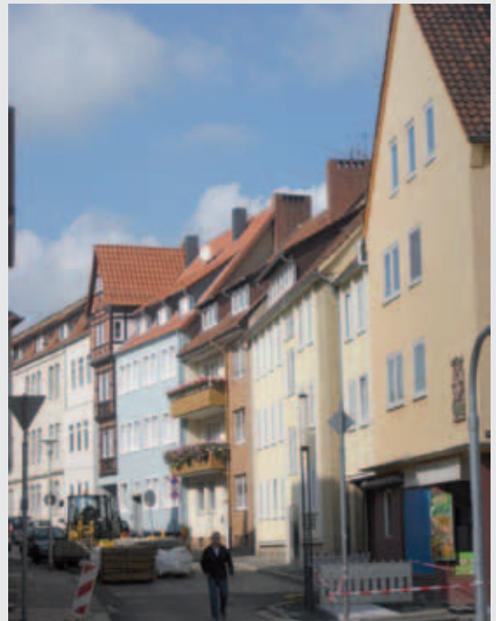
Michaelisstraße vor der Sanierung
