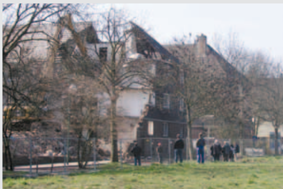
„Zaungäste“ beim Abriss von Wohngebäuden in Essen Borchold/Altendorf-Nord
