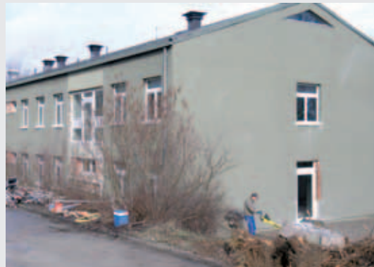
Während der Sanierungsarbeiten
