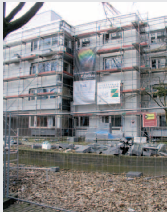
Gebäude während der Sanierung
