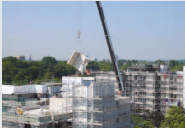
Wohnungsgebäude während des Rückbaus
