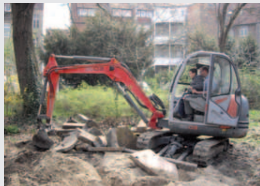
Sanierung des Spielplatzes
