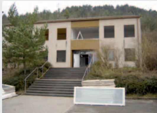
Kasernengebäude in Vorbereitung auf die Sanierung
