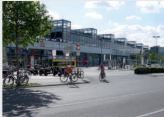
Bahnhof Südkreuz im Zentrum des Stadtumbaugebietes
