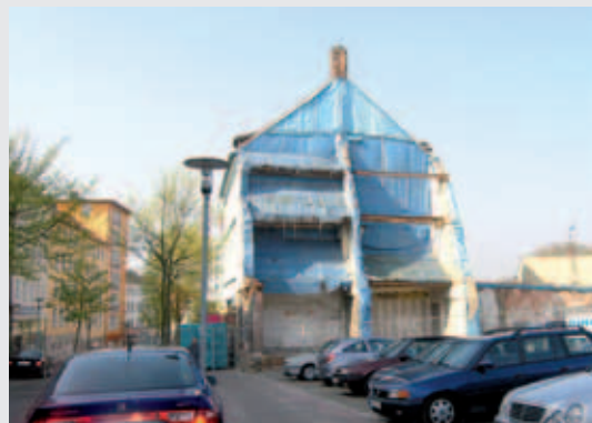
Abriss und Sicherung von Schrottimmobilien
