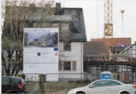
Baustelle des Interkommunalen Dienstleistungszentrums
