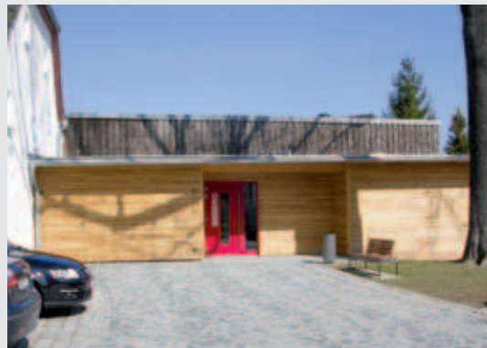
Neubau öffentliche Toilette auf dem Rathausplatz
