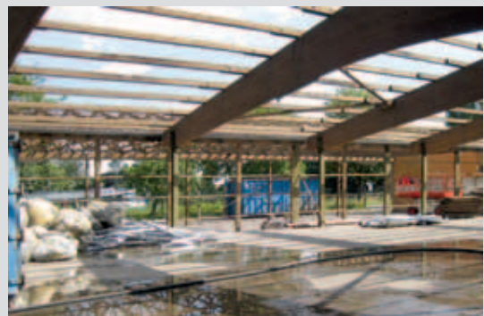
Gewerbebauten vor dem Abriss
