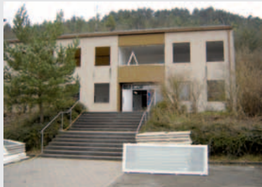
Kasernengebäude in Vorbereitung auf die Sanierung
