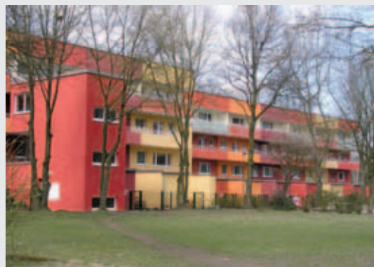
Wohngebäude nach Umbau
