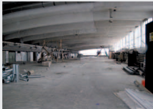
Blick in die noch unsanierte Bogenhalle
