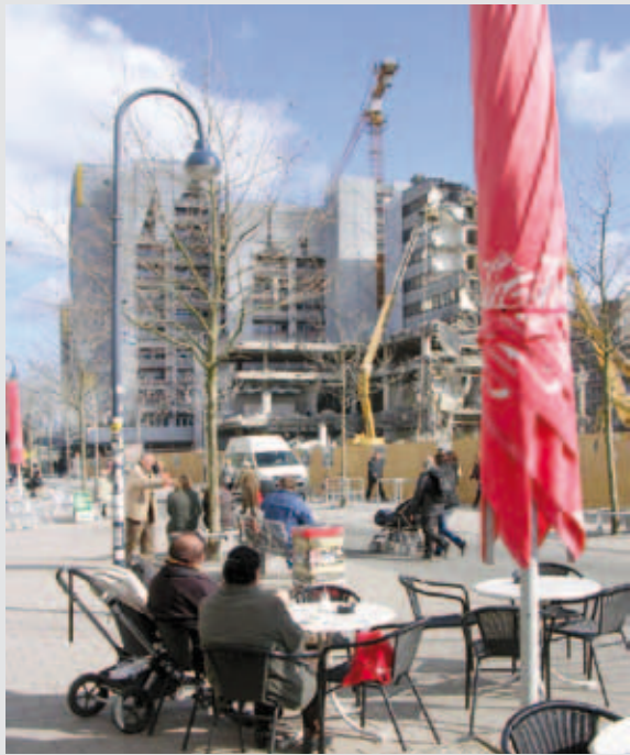
Abriss Einkaufszentrum Hamburg-Altona
