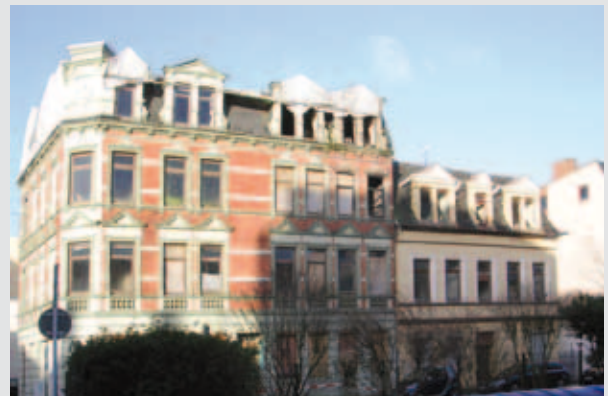
Schrottimmobilien im Quartier
