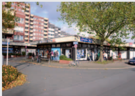
Vor-Ort-Büro des Quartiersmanagements im Stadtteilzentrum
