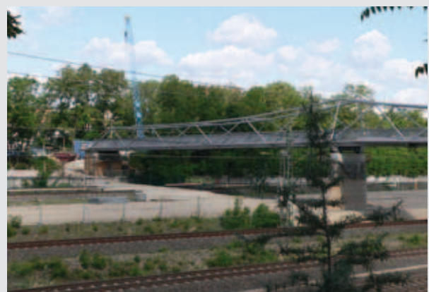
Neue Fußgängerbrücke über die Bahn
