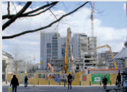
Abriss Frappant-Komplex Große Bergstraße
