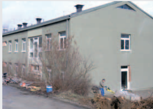
Während der Sanierungsarbeiten
