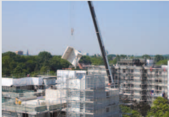
Wohnungsgebäude während des Rückbaus
