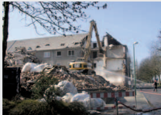
Rückbau der Bestände der Allbau AG
