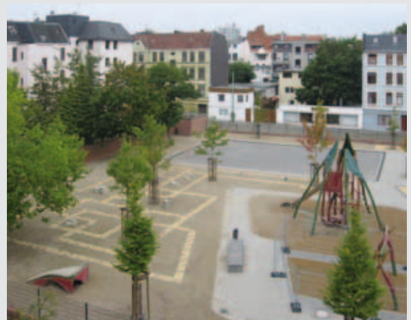
Realisierter Quartiersplatz nach Abriss der Deichschule
