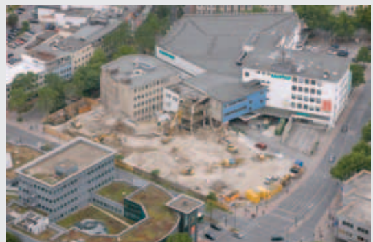
Abrissarbeiten auf Kaufhallen-Gelände 2011
