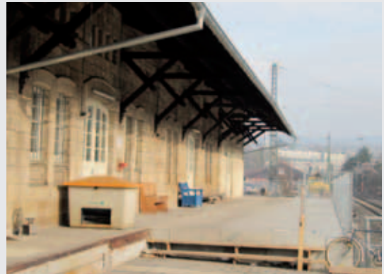
Güterhalle des Bahnhofs Melsungen
