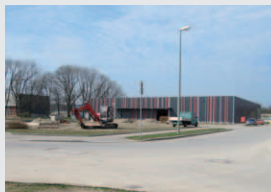
Gewerbeneubau im Gebiet
