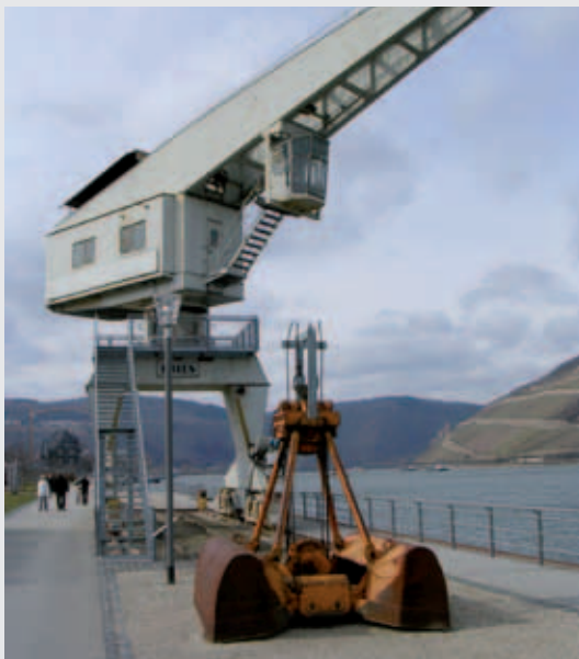
Erhaltung eines Hafenkranes
