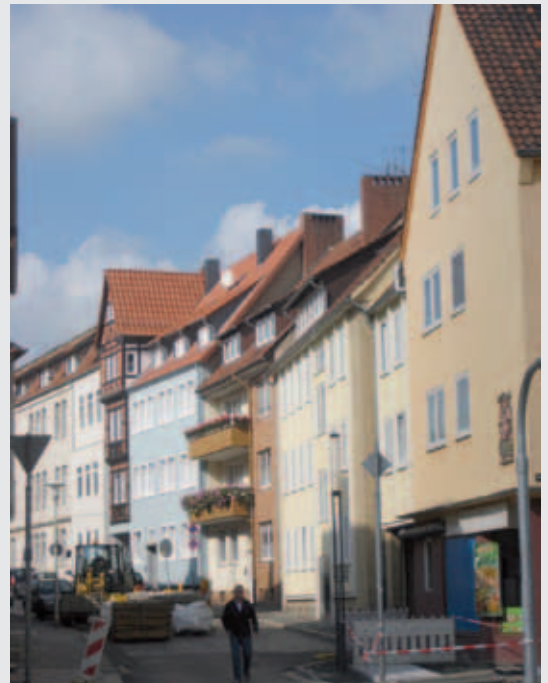
Michaelisstraße vor der Sanierung
