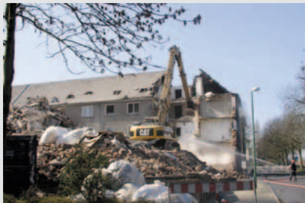
Abriss alter Bebauung macht Platz für Neues
