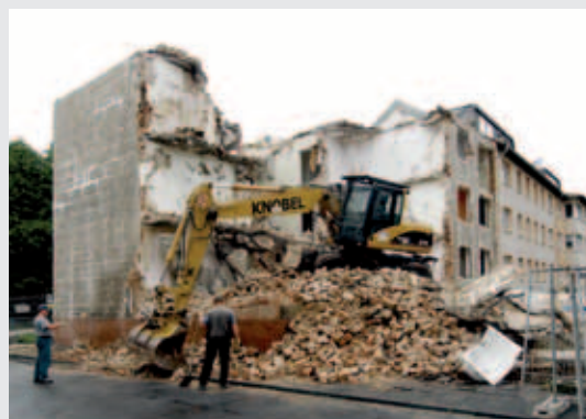
Abriss von Wohngebäuden der gbg
