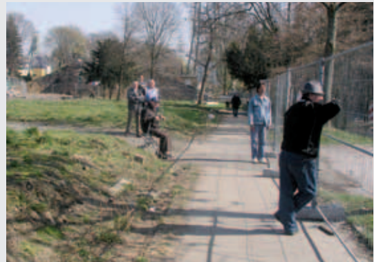
Zuschauer beim Abriss
