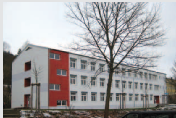
Kasernengebäude nach Sanierung und Umbau
