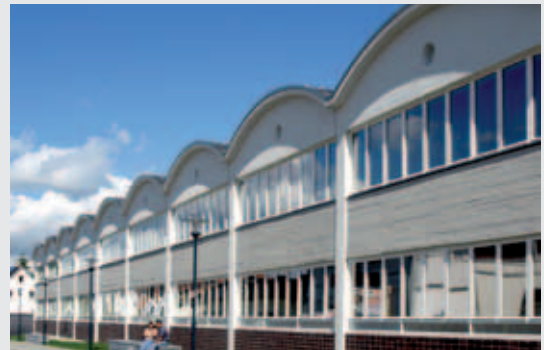
Tonnenhalle nach dem Umbau
