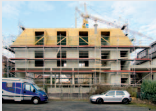
Interkommunales Dienstleistungszentrum: Rohbau des Erweiterungsbaus
