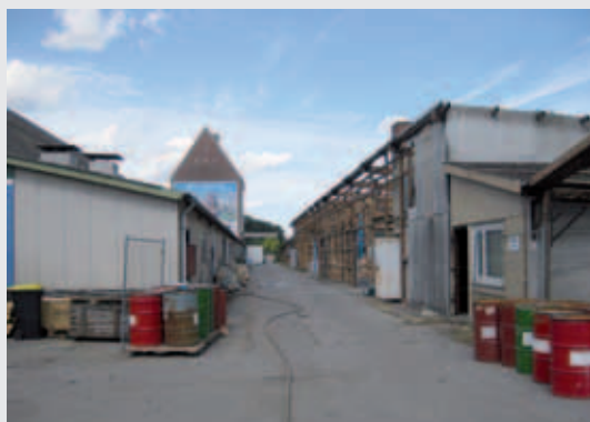
Ungenutzte Gewerbebauten vor dem Abriss
