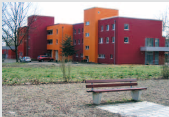
Modernisierter Bestand nach Abriss und Rückbau
