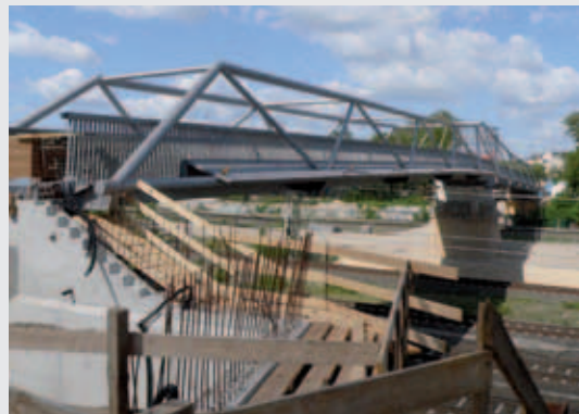
Neubau der Bahnquerung
