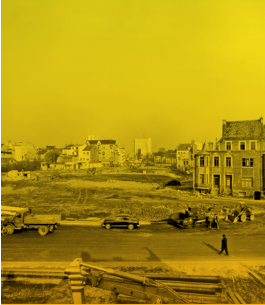
Bau des mehrspurigen Rembertikreuzels in Bremen, um 1967; © Archiv Bremer Zentrum für Baukultur / Foto: Franz Scheper
