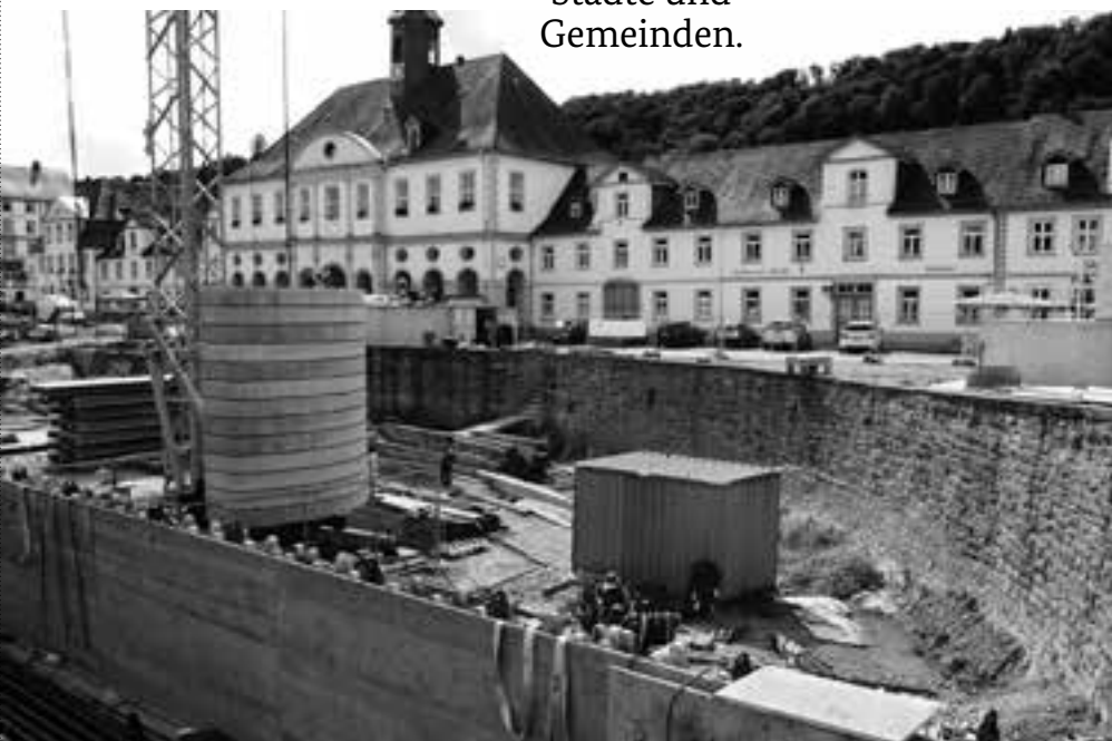
Sanierungsarbeiten 2018, Bad Karlshafen; © Bundestransferstelle Städtebaulicher Denkmalschutz
