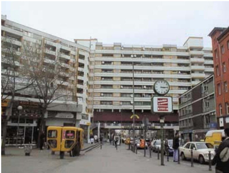
Wohn- und Gebäudekomplex "Zentrum Kreuzberg" am Kottbusser Tor
